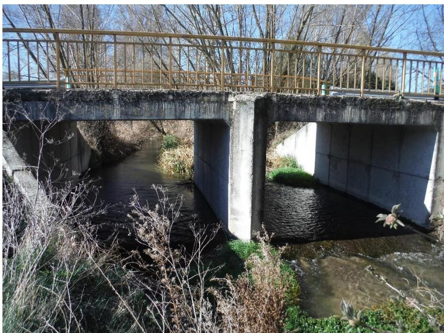
Figura 4. Barrera transversal en forma de puente de dos secciones. Vista desde aguas abajo.
