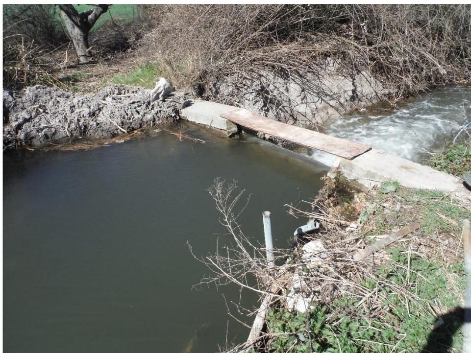
Figura 10. Obstáculo transversal de un único vertedero en el canal de riego.
