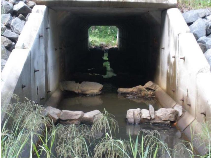
Figura 4. Ejemplo de una rampa piscícola en el interior de una ODT.
