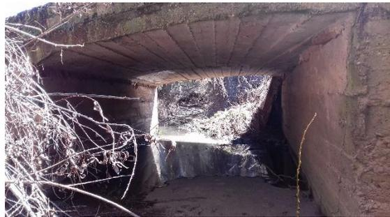
Figuras 2.1, 2.2. Vistas aguas arriba y abajo respectivamente del caño de drenaje rectangular.
