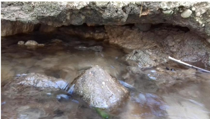
Figura 4. Filtraciones del río bajo la base de la ODT.
