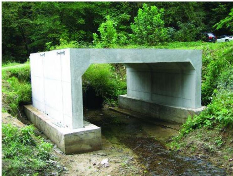
Figura 2. Ejemplo de prefabricado de una ODT rectangular.
