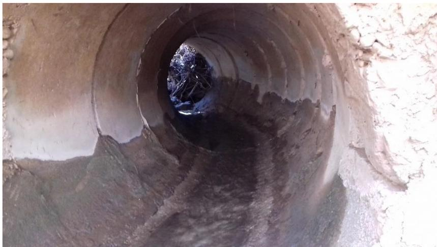
Figura 6. Caño de drenaje circular objeto de ser rellenado e inutilizado.
