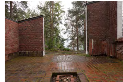
20. Alvar Aalto, Casa Experimental de Muuratsalo (1953)
