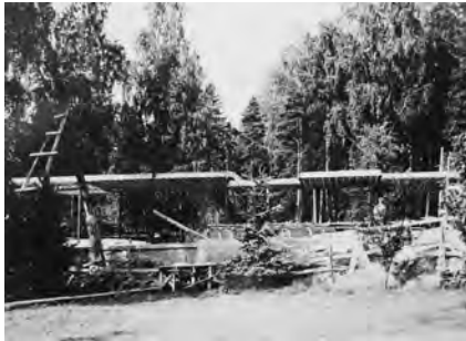
283., 284. 285. y 286. Ejecución de la estructura de Villa Ervi, fotografías publicadas tras su construcción en Arkkitehti 11-12/1951 y SRM Alazado Villa Nuutila, SRM 84/3004 y SRM 84/3005
