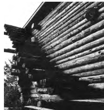
135. Reima y Raili Pietilä, exterior del edificio de galería, sauna y piscina en Särestö (1972)
