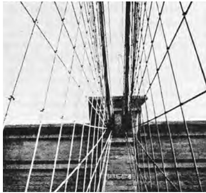
02. La contradicción entre la forma arquitectónica obsoleta de los pilones de piedra natural del puente colgante y la estructura abstracta, "no arquitectónica" de los cables, es evidente. En la parte de la estructura construida con los materiales convencionales y cargada a compresión, el proyectista no ha sido capaz de liberarse del peso de la tradición, y ha enmascarado la estructura con arquitectura deshonesta, innecesaria. Aparentemente ha hecho un esfuerzo consciente para generar belleza. La construcción suspendida fue una situación completamente nueva, de adaptación irreconciliable con la ornamentación de las clásicas estructuras comprimidas.
