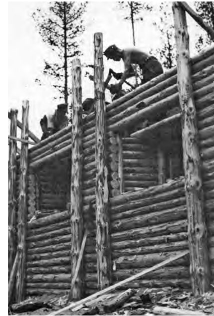
174. Militares trabajando en una de las características construcciones de guerra
