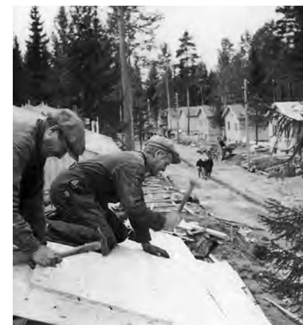
36. Construcción de casas de veteranos donadas por el estado sueco, Västerås, Lahti.
