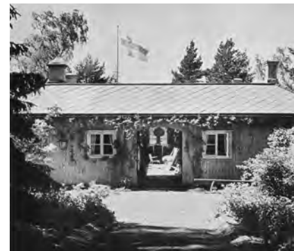
175. Fotografía de Villa Oivala tras su reforma en 1936
