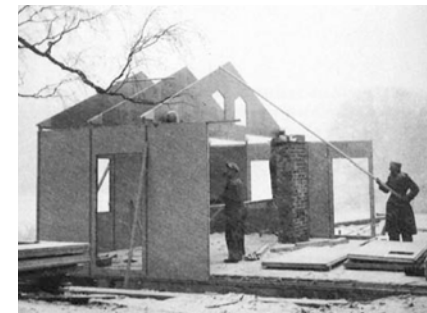
290. Sven Markelius, construcción de un prototipo del System House en Estocolmo en (1942), base para construir su propia vivienda en Kevinge
