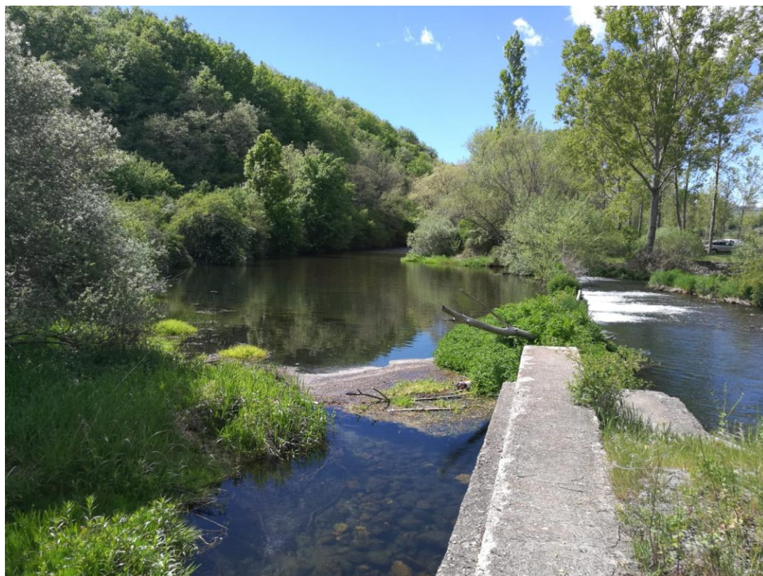
Figura 16: Aspecto de la sección 11 desde el margen derecho.
