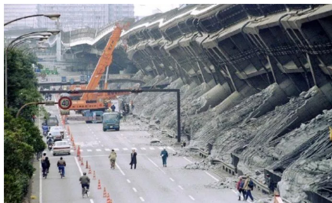
Figura 25. Demolición autopista Fuente: Hanshin Awaji Daishinsai, Fotografo
