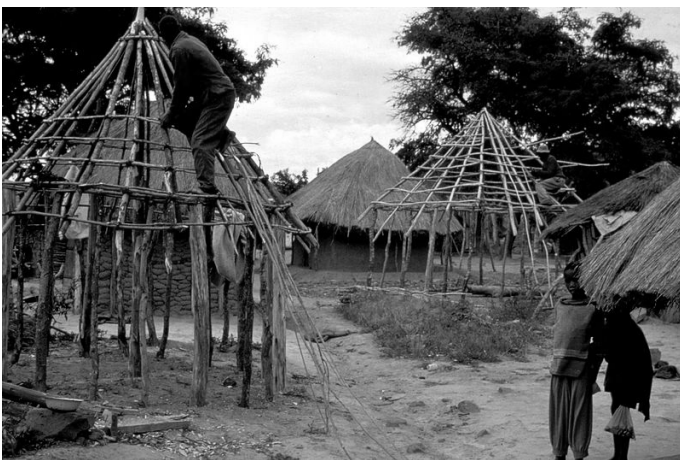
Figura 41. Construcción vivienda tradicional africana.
