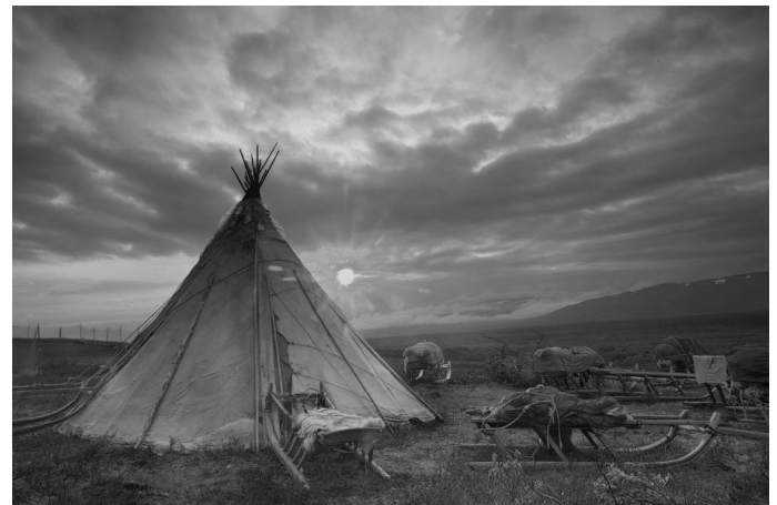
Figura 2. Chum. Construcción textil sobre postes y tensados con cuerdas propia de Siberia.
