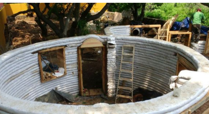
Figura 21. Proceso de montaje. Super ADOBE
