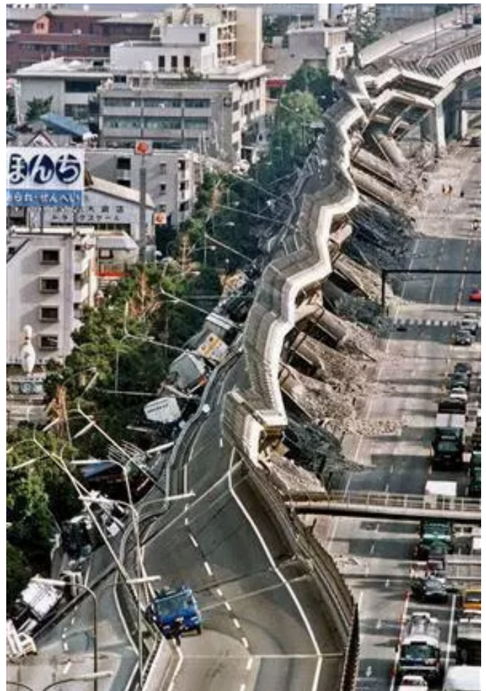
Figura 23. Derrumbe autopista elevada en la ciudad de Kobe Fuente:1995, Taichiro Yoshino, Fotógrafo
