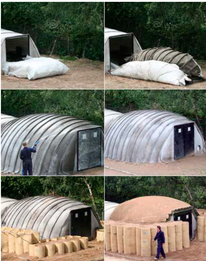
Figura 25. Proceso de montaje Concrete Cavas Shelter.
