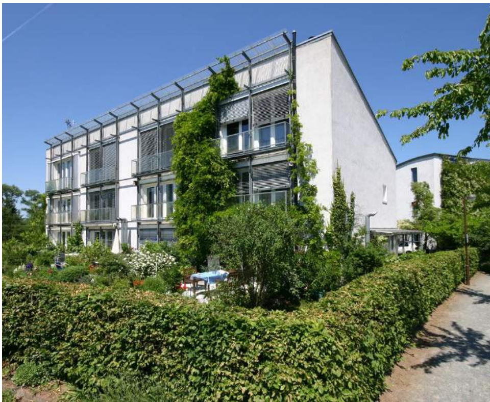
Primera vivienda passivhaus
