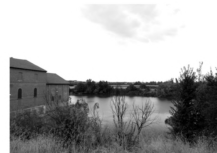
5. Vista hacia el río y el campo con la imagen de la central.
