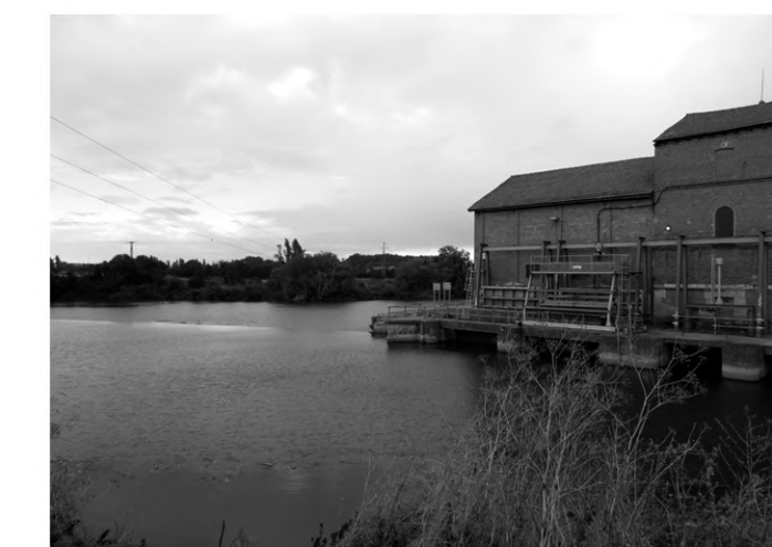
7. Vista al río y salto de agua, junto con la central eléctrica.
