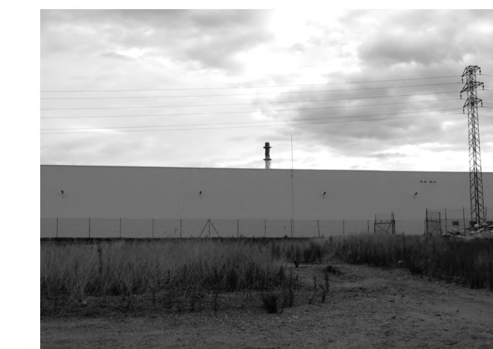
8. Nave de Michelin de fachada neutra y la chimenea más alta.
