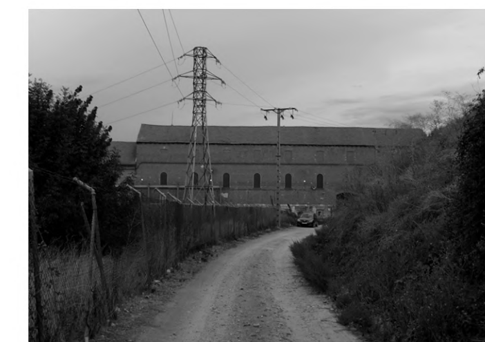
6. Camino a la central eléctrica y relación con el talud.
