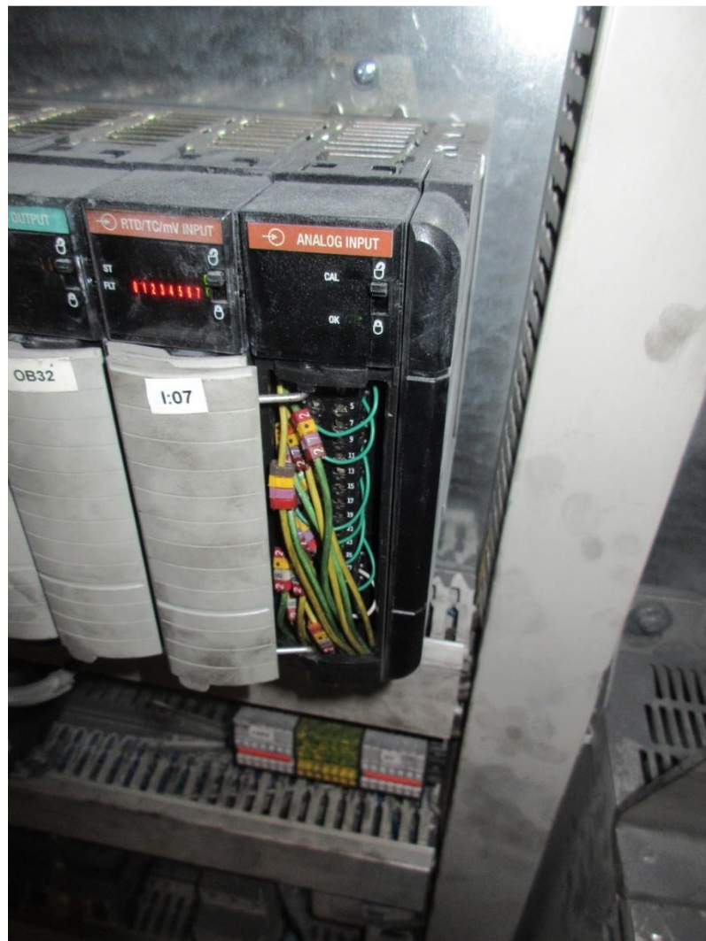
Figura 7: Carta instalada en el chasis.
