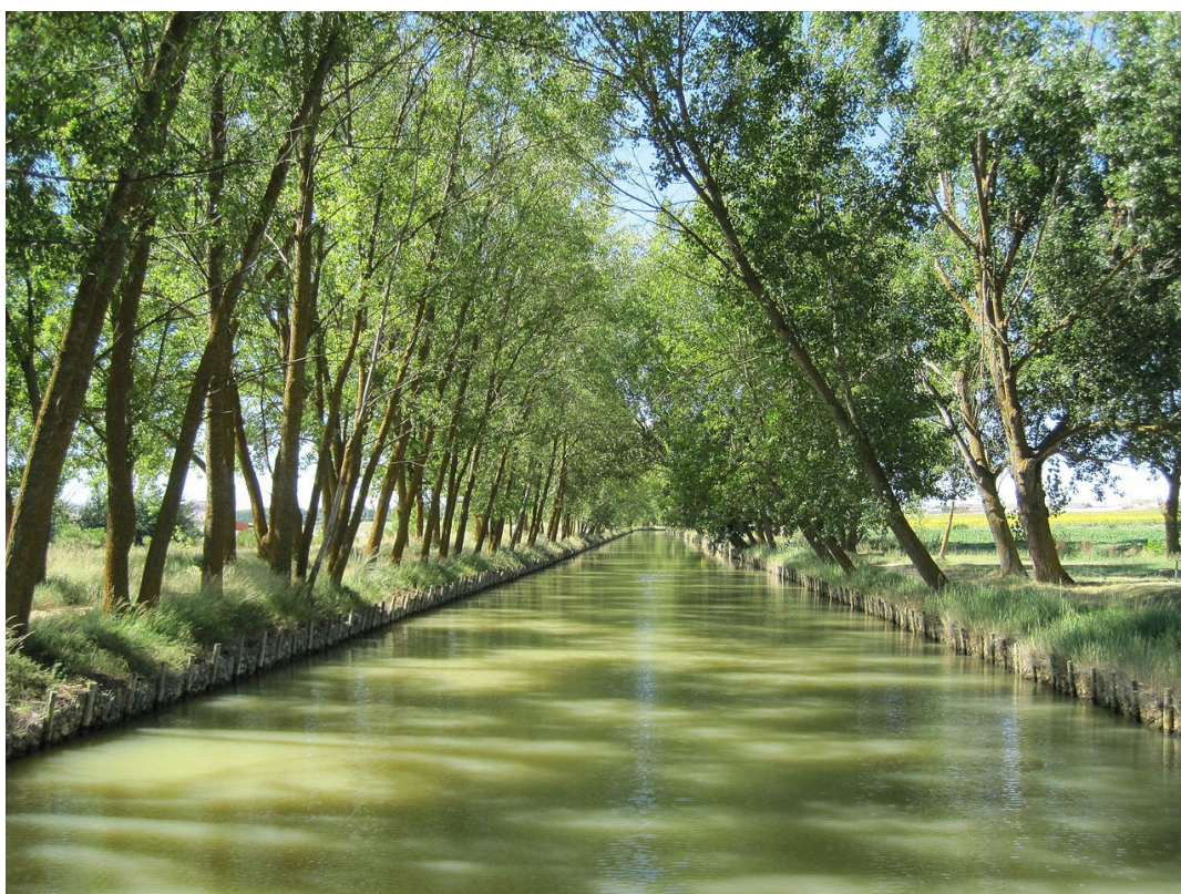
Vía Verde al final del entorno urbanizado del Canal. Otra posibilidad del entorno de la Dársena. Web Oficial del Ayuntamiento Medina de Rioseco
