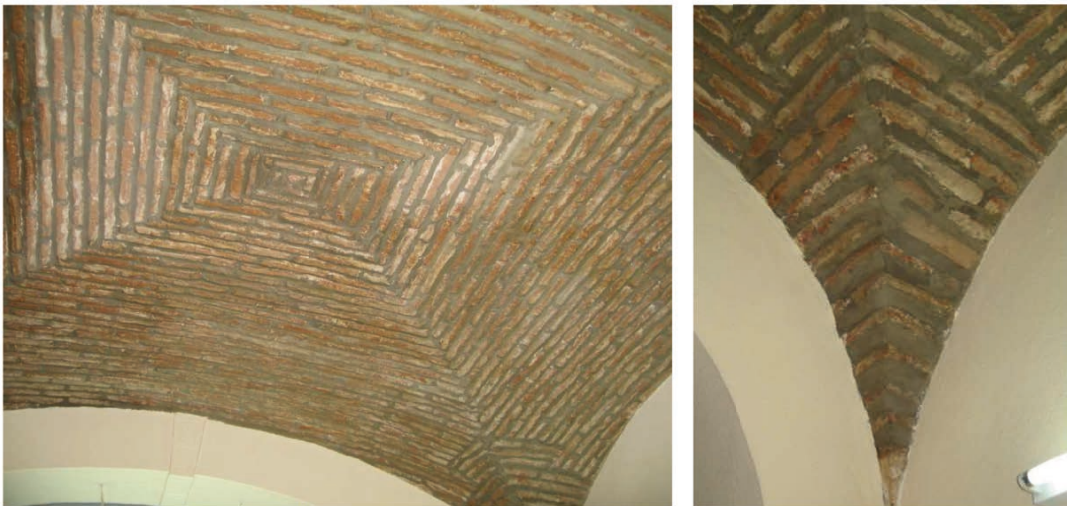
Bóveda por arista de rosca sin encalar en planta cuadrada perteneciente a La Casa del Navegante (BIC) en Montijo (Badajoz)
