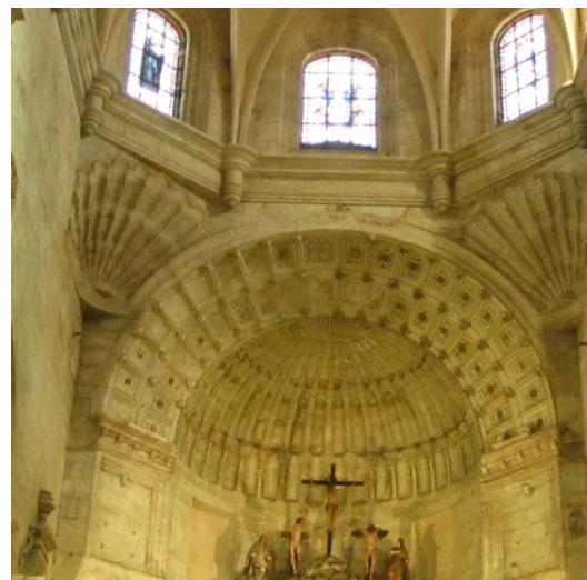
(Figura 65: Ábside en media naranja avenerado sobre trompas y pechinas, planta y embocadura sobre arco de medio punto en Las Bernardas de Jesús, Salamanca).
