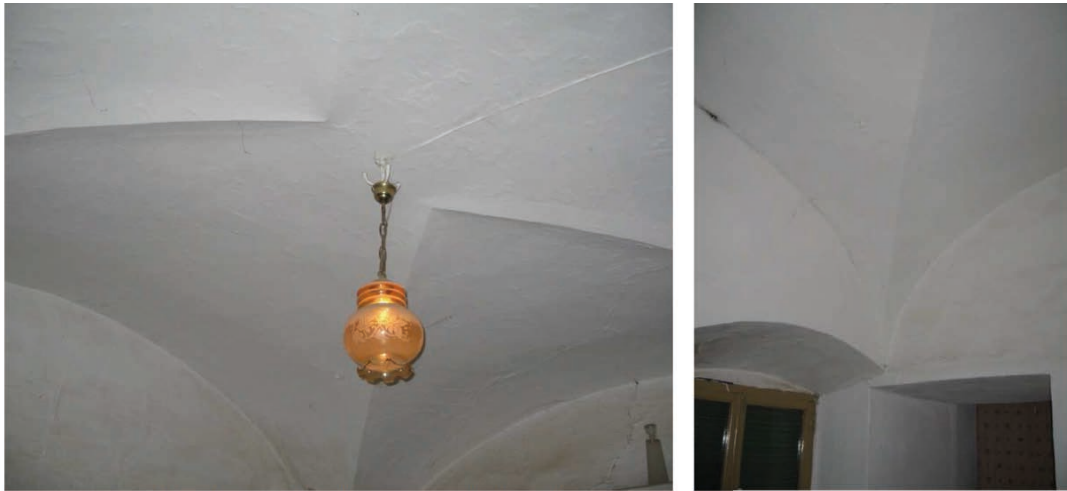
Bóveda por arista de rosca encalada en planta rectangular perteneciente a habitación de Vivienda Tradicional en Montijo (Badajoz)
