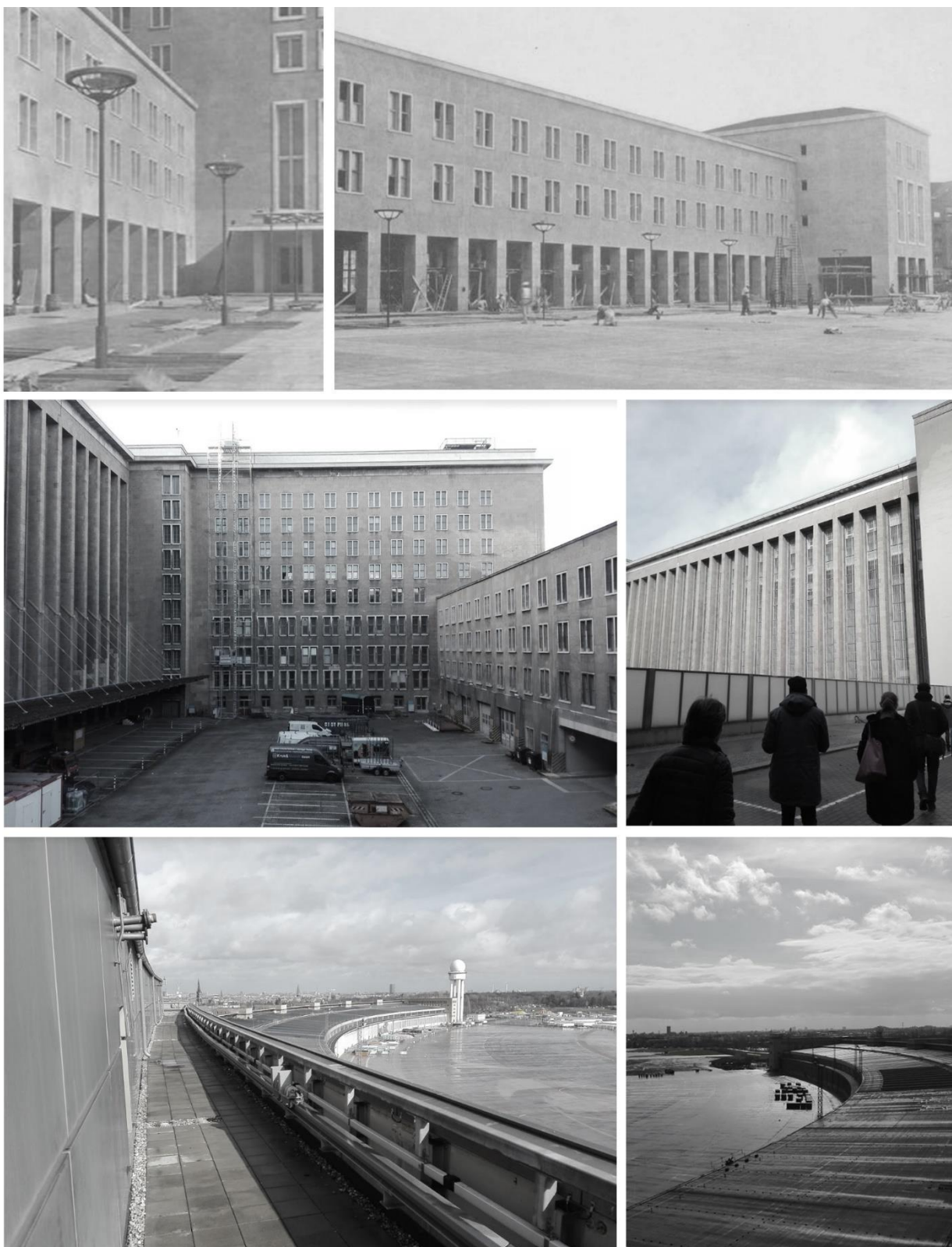
28. El edificio de aeropuerto. Vista del exterior, del interior de los patios y sobre la cubierta.
