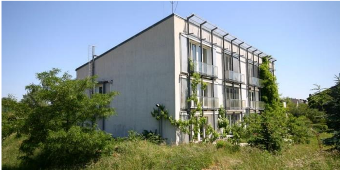
Figura 76. Fotografía de la considerada como la primera casa Passivhaus de la historia en Darmstad. Fuente: Google imágenes.
