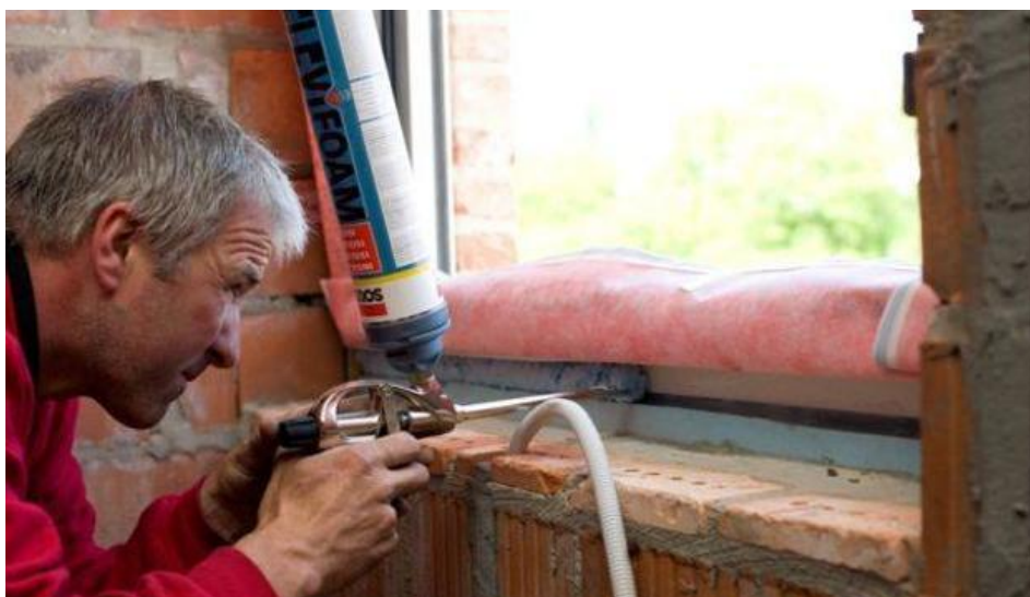
Figura 105. Fotografía de un operario sellando convenientemente el contorno de una ventana. Fuente: Google imágenes.
