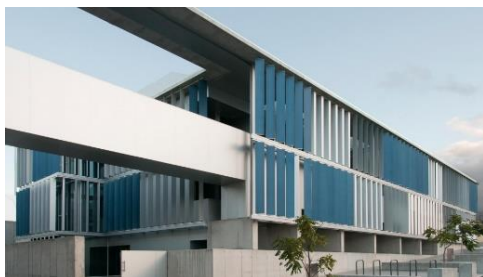
Figura 102. Fotografía de ejemplo de edificio con protecciones solares en forma de lamas. Fuente: Google imágenes.
