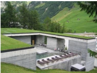
Figura 110. Fotografía de la cubierta vegetal del edificio de las termas de Vals de Peter Zumthor. Fuente: Google imágenes.
