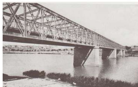
Fig. 25. Puente de Hierro sobre el Duero, Siglo XIX.
