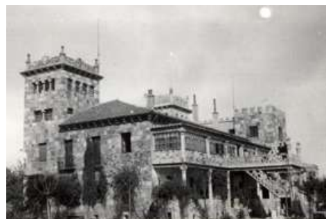
Fig. 16. Fachada sur y lateral oeste.
