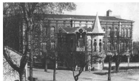
Fig. 30. Dos aspectos de la Caseta del Guarda, derribada en 1966.
