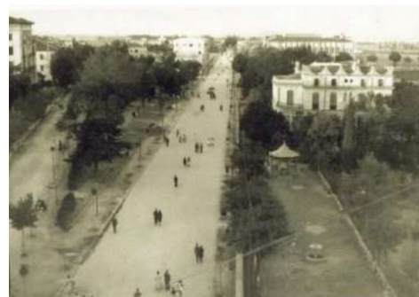
Fig. 01 Vista aérea de la Avenida de Requejo. En primer término, a la derecha el Chalet de
