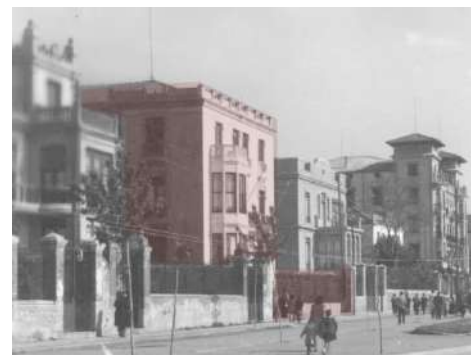
Fig. O5. Fachada sureste del hotel Juan Calero en el frente septentrional del Paseo (años cuarenta).
