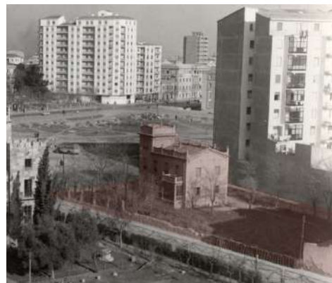
Fig. O1. Fachada sur y oeste del hotel Julio Hernández Alonso.
