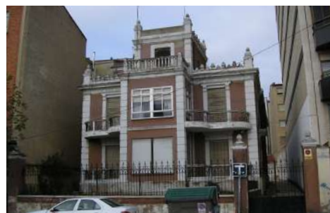
Fig. O2. Estado reformado del hotel de Gregorio Gato. (Foto tomada entorno al año 2015).
