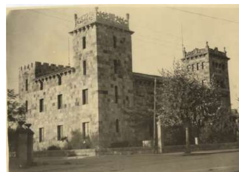
Fig. 08. Fachada principal orientada al sur, y lateral este.
