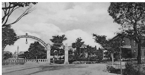
Fig. 26. Aspecto del Paseo de la Glorieta (Avda. de Requejo) a principios del S.XX. Al fondo la entrada de Santa Clara; a la derecha calle de la Amargura y el cafetín (c.a. 1910).
