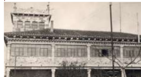
Fig. 14. Segunda modificación de la fachada posterior (galería acristalada).
