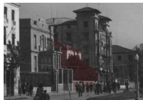
Fig. O7. Fachada sur del Hotel Miguel Fernández en el frente septentrional del Paseo.
