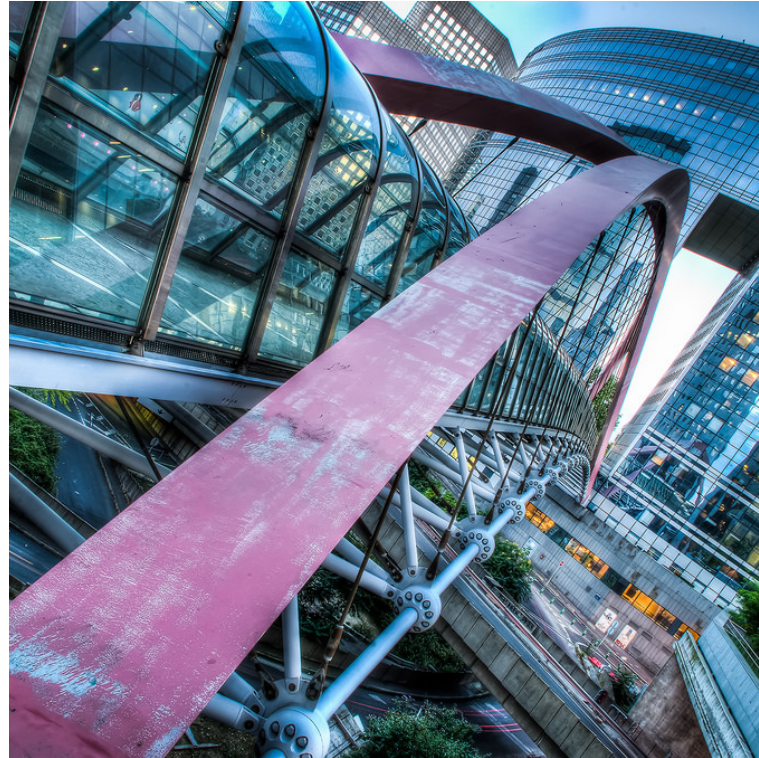
Figura 08. Vista de los principales componentes estructurales del puente.
