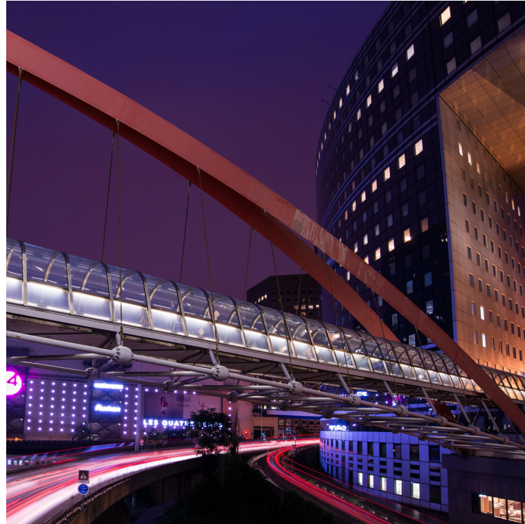
Figura 06. Autopista bajo el Japan Bridge.
