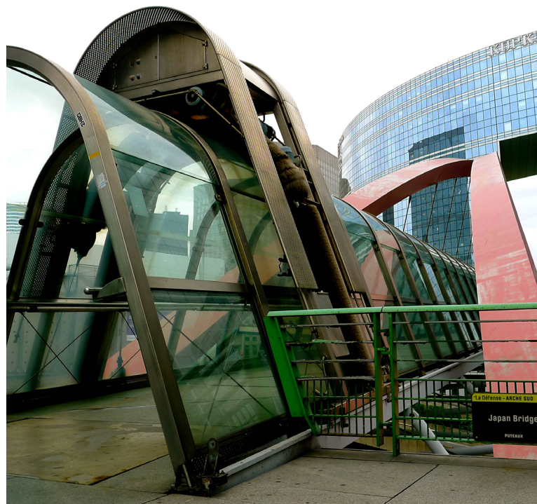
Figura 20. Sistema de limpieza automatizado.
