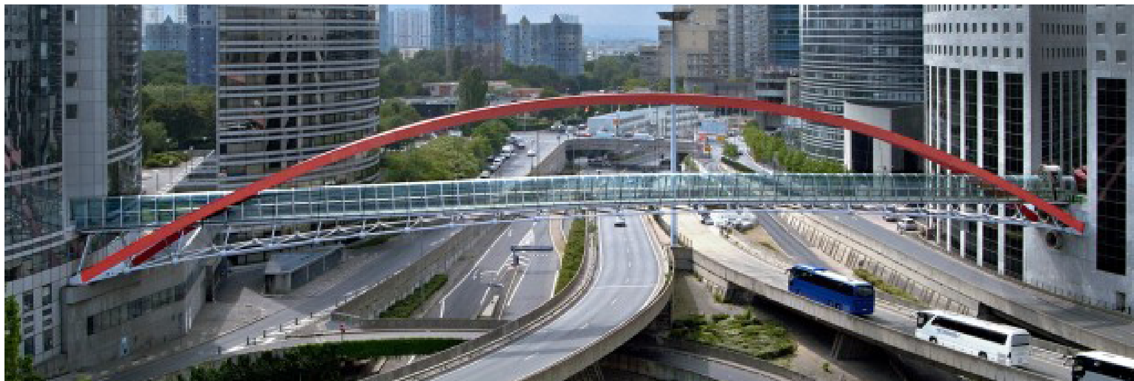
Figura 18. Vista del puente en su conjunto urbano.
