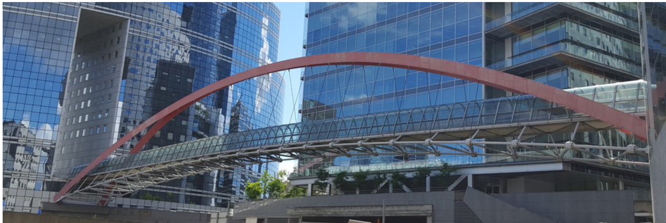
Figura 13. Vista completa del puente.
