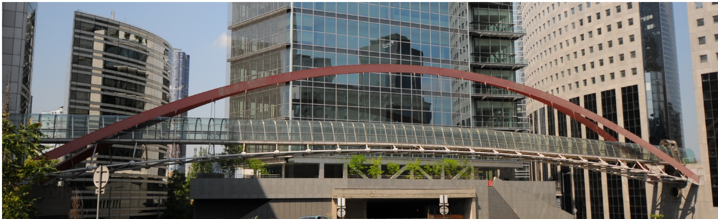
Figura 04. Vista general del puente Japan Bridge (1994).
