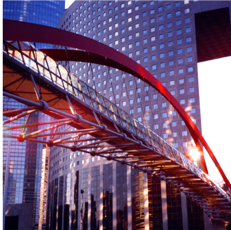
Figura 05. Vista inferior del puente Japan Bridge en conjunto con la Torre Pacifico.
