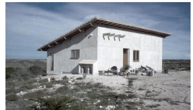
76 Detalle en esquina. Construcción GREB.
