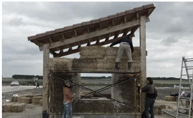
59 Casa de paja. La lama foundation. Postes y vigas exteriores.
