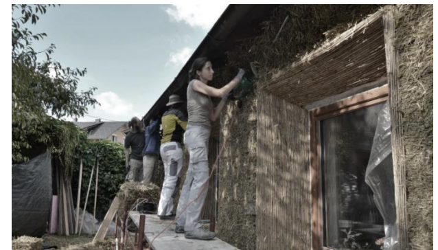
95 Acabado panel fibras de madera. Sistema Wrapping.
