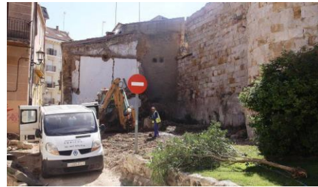
(Figura 49): Derribo Calle Feria 11
