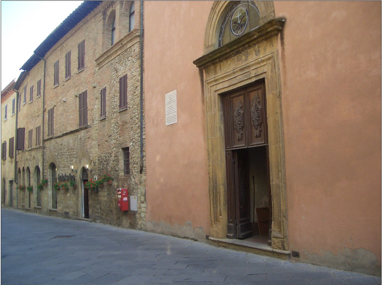
Lámina 1: Iglesia de San Lino (Volterra)
