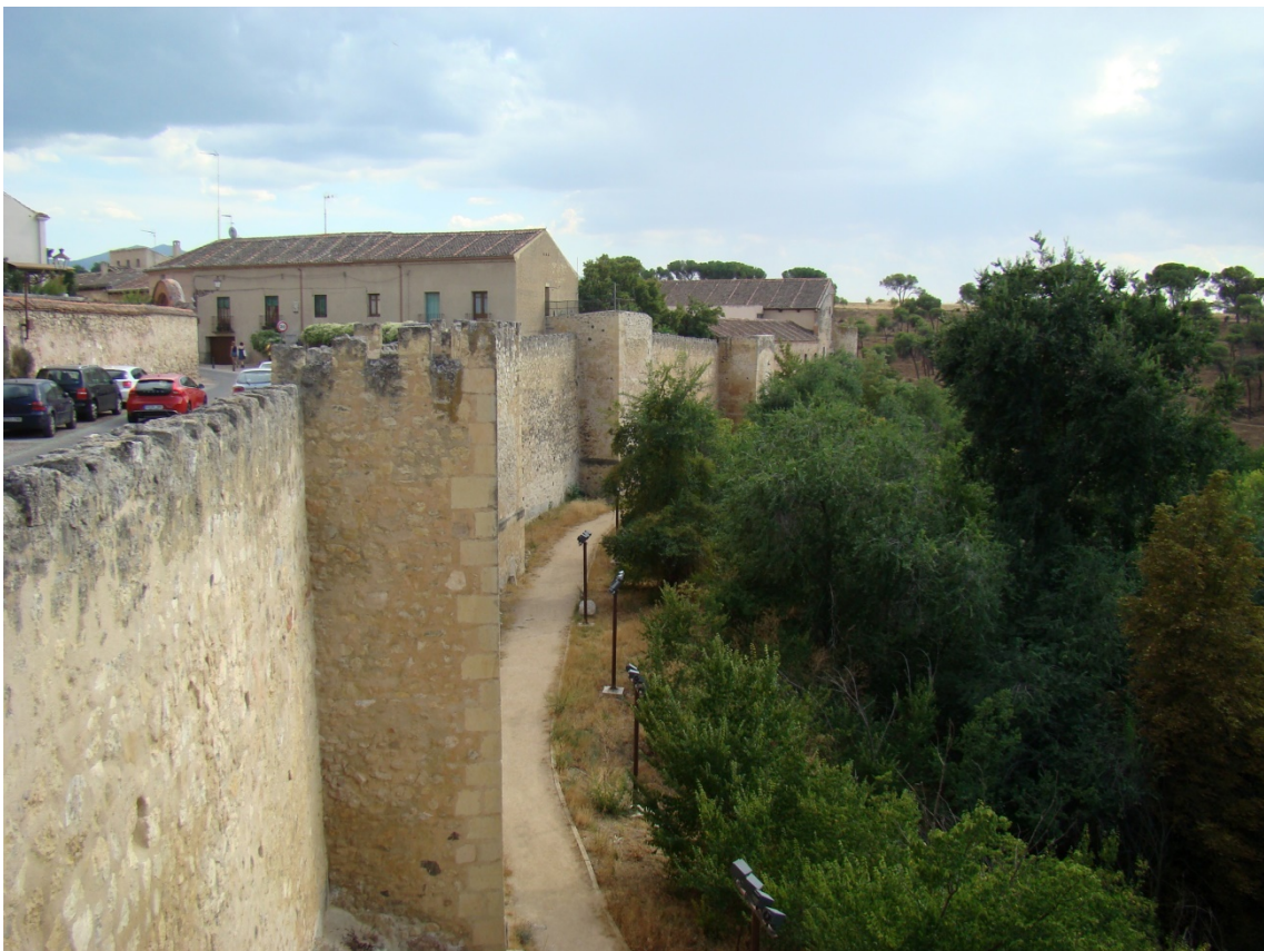
Muralla sobre el paseo del río Clamores. Foto: E. Delgado
