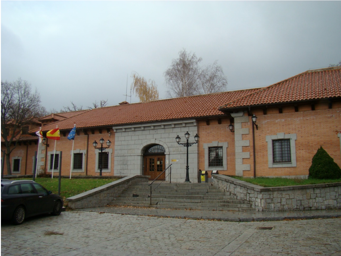
CENEAM (Valsaín). Fachada principal. Foto: E. Delgado
