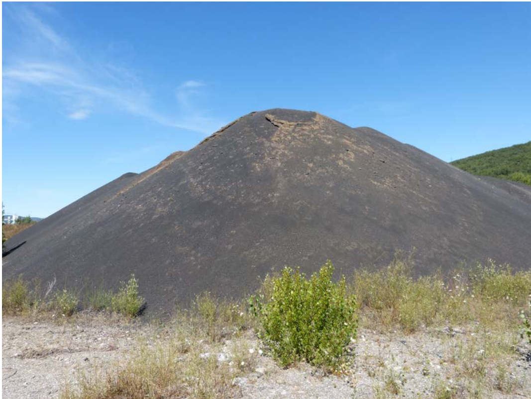
La Robla. Escombrera. Foto: E. Delgado
