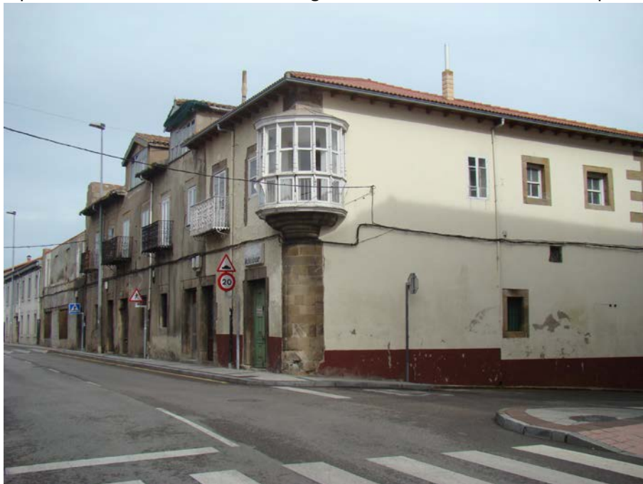
Avenida de Cantabria. Casa con mirador y sillares. Foto: E. Delgado
