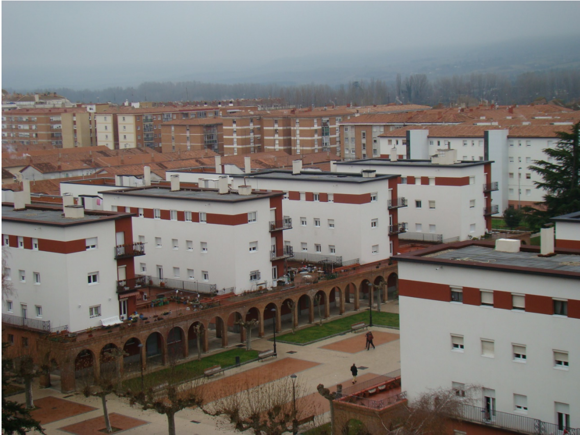
El Carmen. Casas del Hogar Prim era Fase y grupo de Viviendas subvencionadas. Foto: E. Delgado
