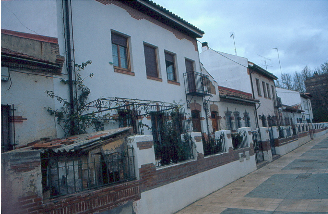
Casas Baratas. Elevación de una planta. Foto: E. Delgado 2000
