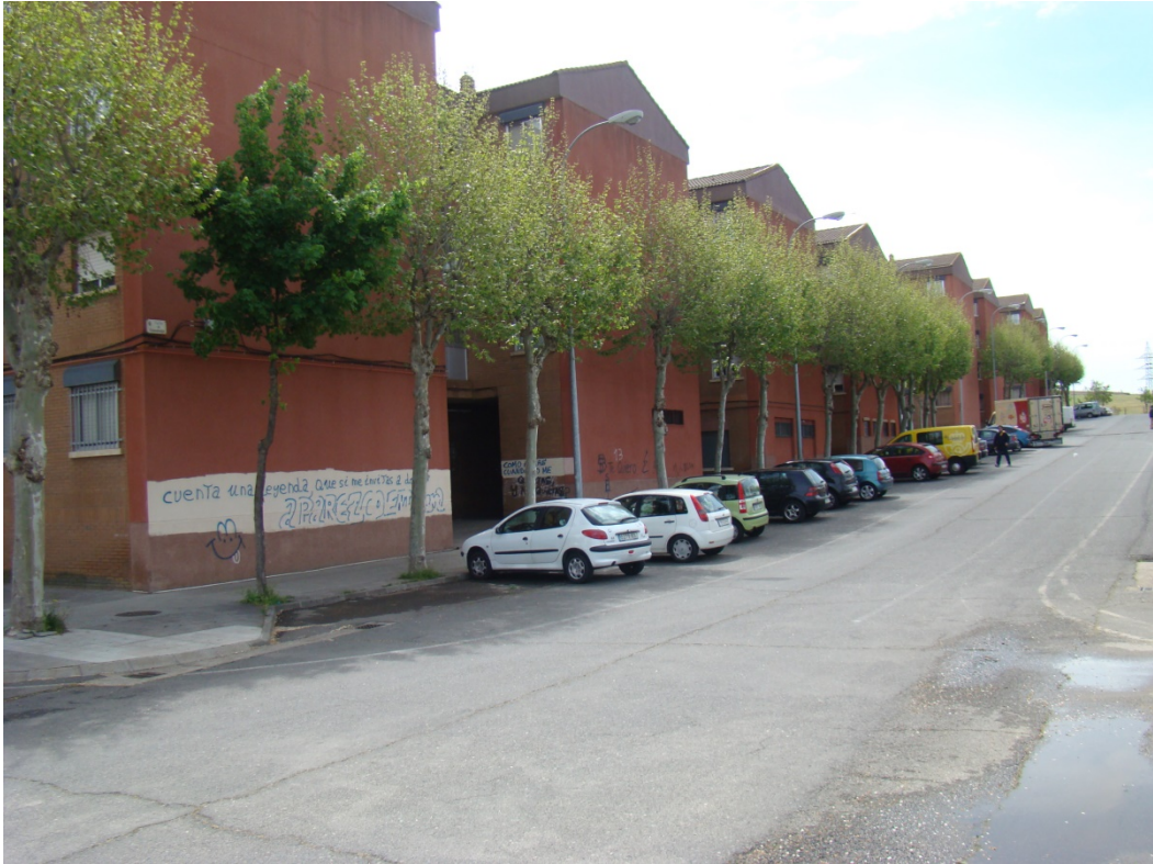
Barrio de Buenos Aires. Bloques de viviendas. Foto: E. Delgado
