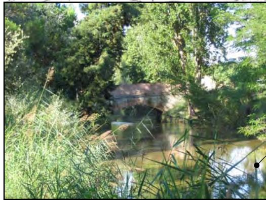
Foto 33: Puente de Fuentes Claras en P.K. 6+621
