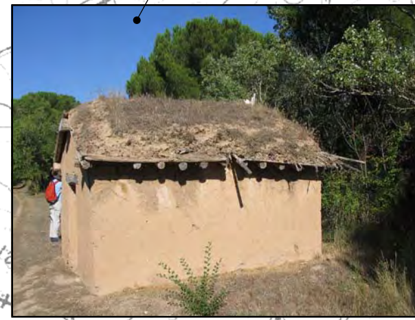
Foto 12: Caseta de adobe en el P.K. 1+250
