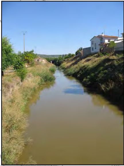
Foto 40: Canal del Duero desde Puente de Sardón
