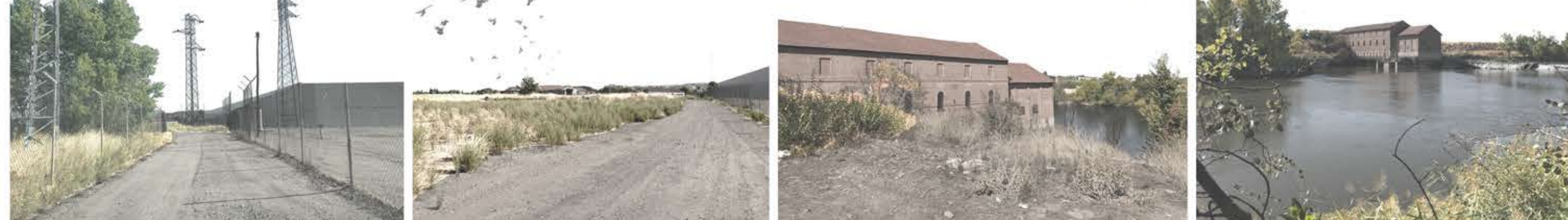
CAMINO DE LLEGADA A LA PARCELA ENTRADA AL ÁREA DE PARCELA MINICENTRAL ELÉCTRICA EXISTENTE VISTAS DESDE EL OTRO LADO DEL RÍO
