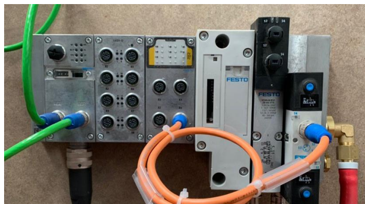
Ilustración 16: Actuador neumático operador.
