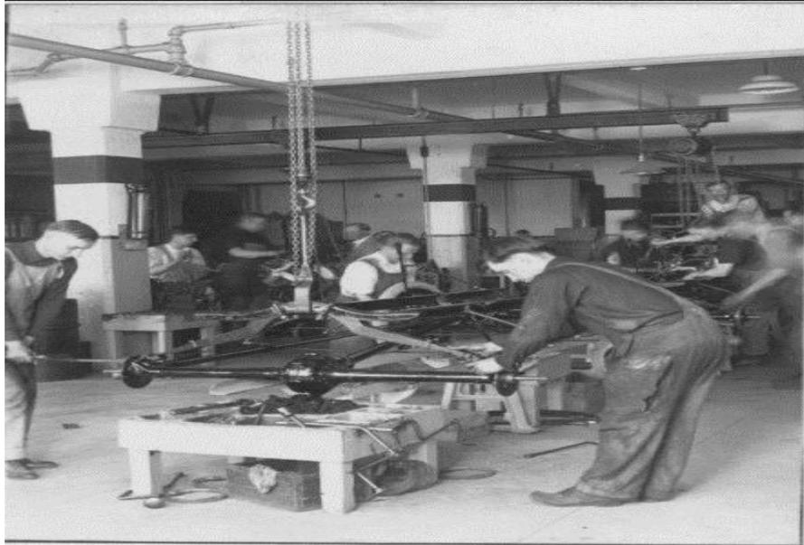
[Fig. 5 Ensamblaje de chasis y ejes en cadena de fábrica Ford] (Camós, 2013)
