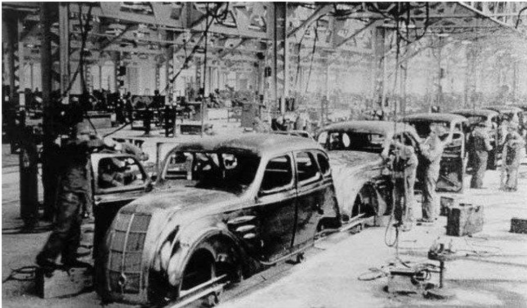
[Fig. 8 Línea de ensamblaje del Toyoda AA en 1936] (Todoautos, 2011)
