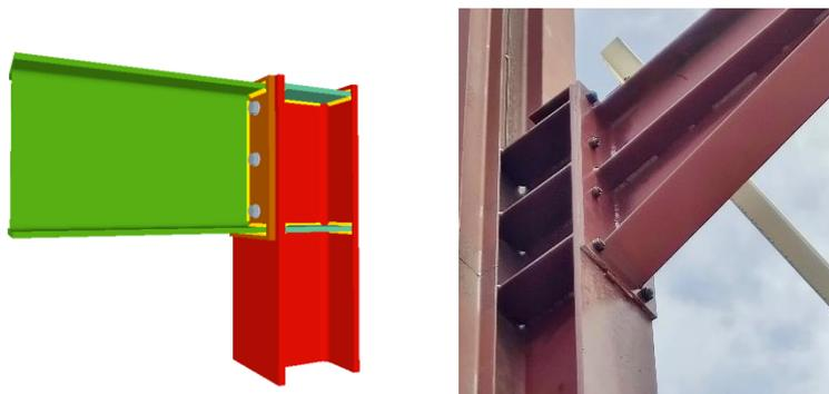
*Figura 1.10: Unión por tornillos*
