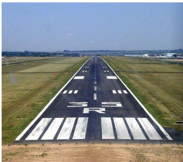
Figura 4.5: Ejemplo de señalización en una pista de aeropuerto, Fuente: *Diario del Viajero* (visitado 15-03-2020).
