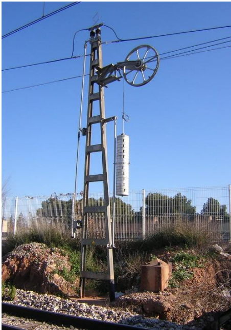
Figura 20. Imagen detallada del conjunto de compensación (izquierda) y esquema de funcionamiento de la polea (derecha) [43]
