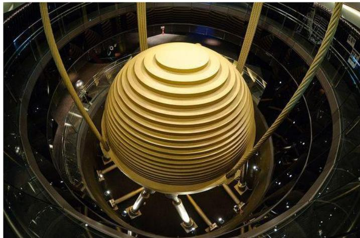
Figura 1.4. Imagen del TMD instalado en el rascacielos Taipei 101. [10]
