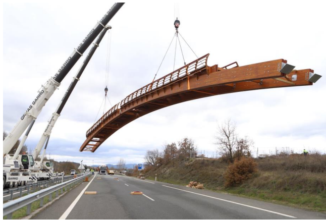
Ilustración 14. Izado y posicionamiento de la pasarela I. [7]
