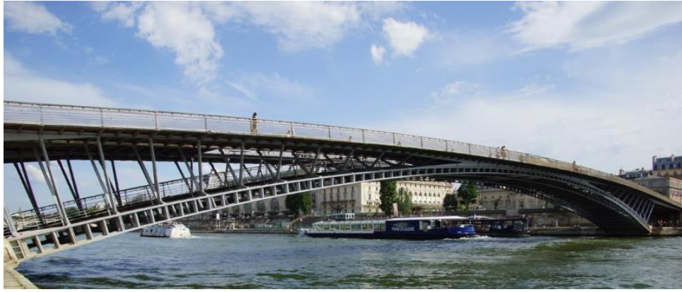
Ilustración 2. Pasarela Solferino en Paris, 1999. [2]
