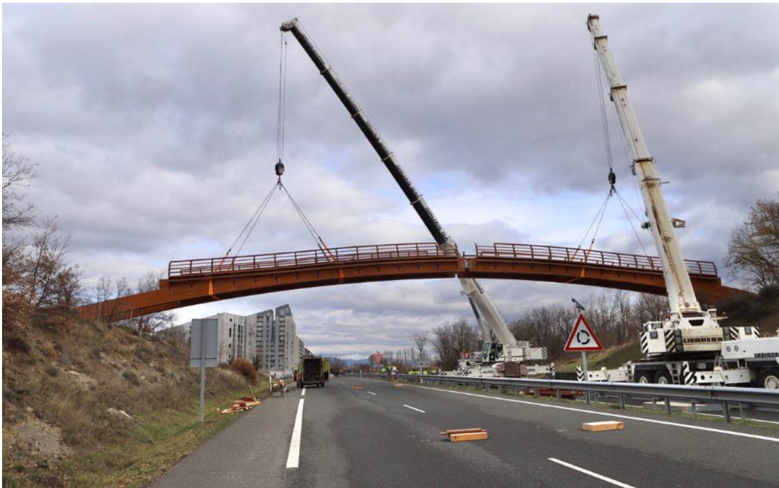
Ilustración 15. Izado y posicionamiento de la pasarela II. [7]
