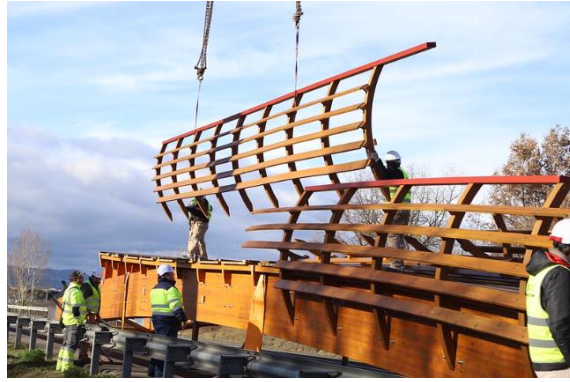
Ilustración 13. Montaje de barandillas. [7]
