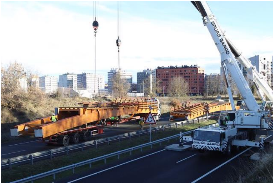
Ilustración 11. Transporte e izado de la pasarela. [7]
