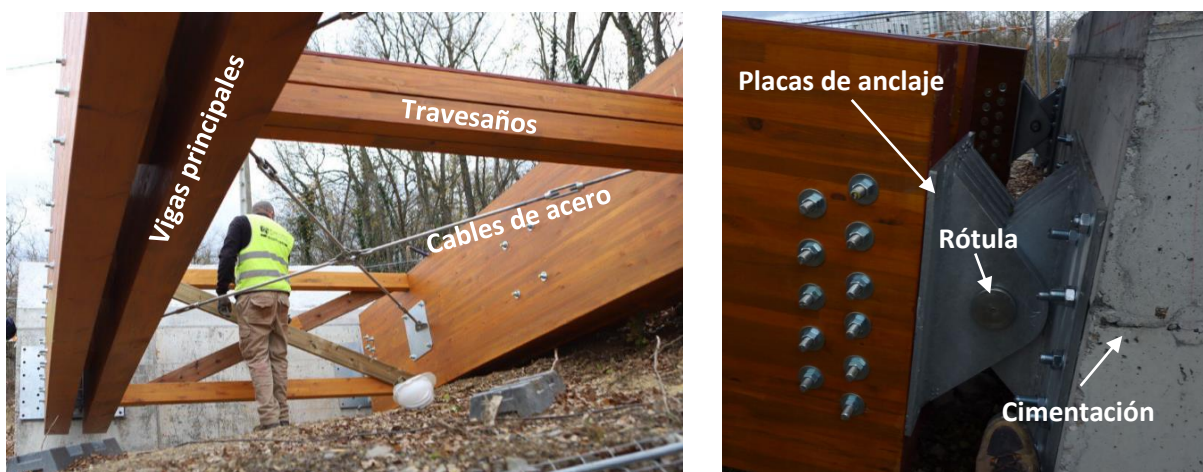
Ilustración 17. Componentes de la estructura. [7]
