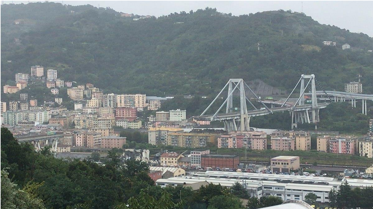
Figura 1. Puente de Morandi tras el derrumbe. [1]
