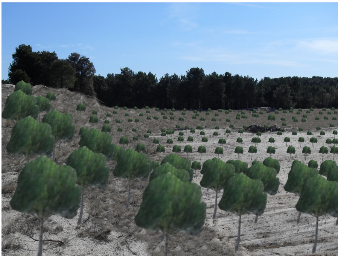
Foto 4. Situación objetiva de la misma zona que la Foto 3. Se ha rebajado la pendiente del talud, lo que ha permitido que la vegetación herbácea colonice esas zonas. También se ha realizado una plantación con pino resinero, que es el que existía en la zona antes de la explotación. La densidad de la plantación puede no ser real en la foto, ya que esta imagen es orientativa de la situación ideal.
