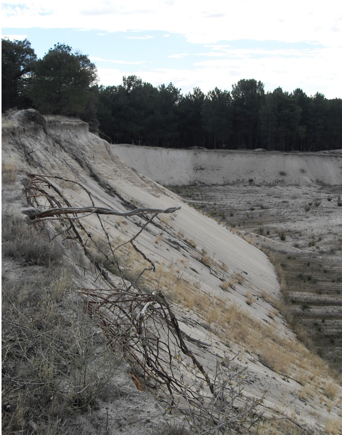
Foto 28. Detalle del talud norte de la cantera B. Se aprecia la fuerte pendiente del talud.
