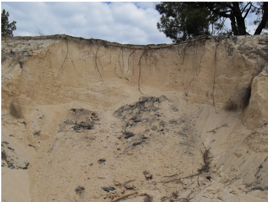
Foto 29. Detalle de derrumbamiento producido por la excesiva pendiente.
