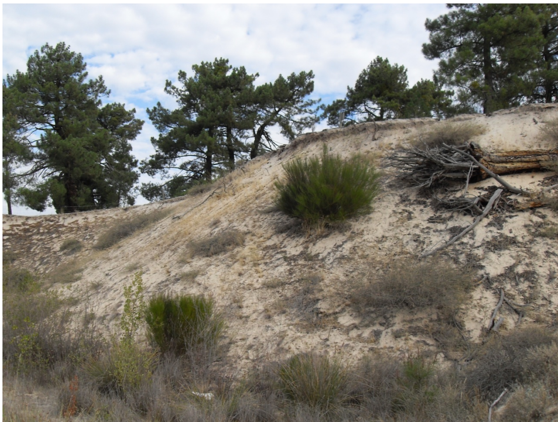
Foto 1. Situación actual de un talud. Se observa que la vegetación ha empezado a colonizar la parte inferior (con abundante humedad, puesto que está más baja que la cota freática), sin embargo no puede colonizar el talud debido a su excesiva pendiente.
