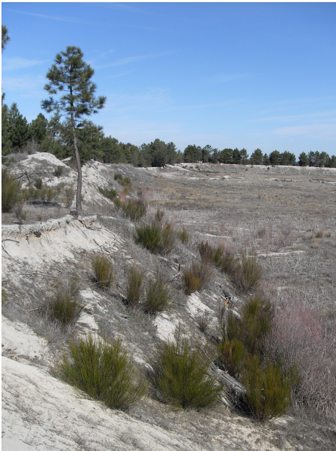
Foto 31. Detalle del talud oeste de la cantera C. El talud no es muy pronunciado, lo que posibilita la aparición de vegetación, sin embargo en su parte posterior no se ha restaurado en su totalidad, quedando partes con mucha pendiente y raíces al descubierto.
