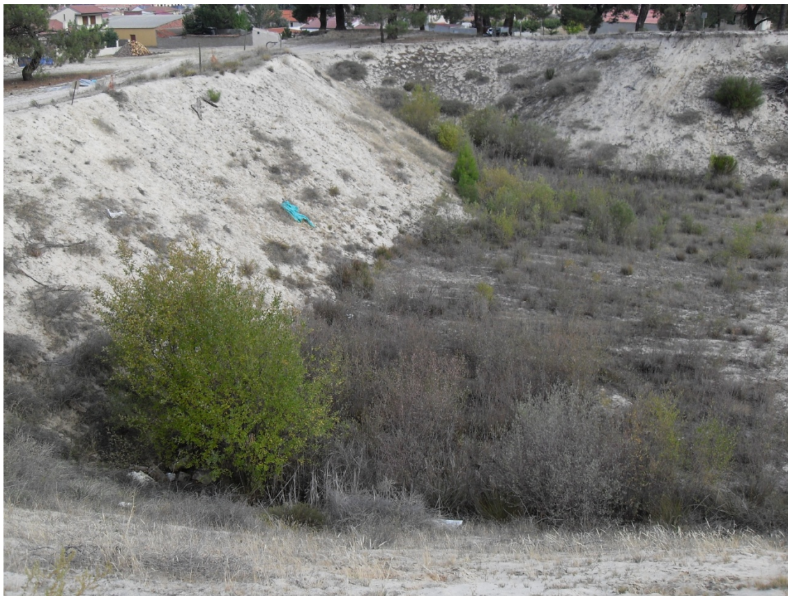
Foto 26. Detalle de las zonas más húmedas en la cantera A1. Puede observarse la pendiente del talud (en torno a 60%) y el núcleo urbano de Mudrián al fondo.
