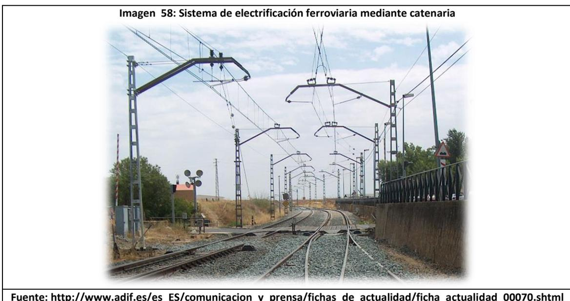
Además, este sistema permite la instalación de contrapesos en el poste que dotan a la estructura de una mayor rigidez o posibilita que se usen varios hilos en lugar de uno lo que mejora la conductividad y la velocidad a la que pueden circular los trenes, por esa razón sumado a la alta seguridad del sistema es el método de electrificación más extendido en el ferrocarril.
