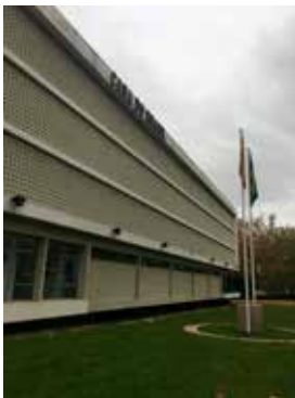
Fig 6. Vista exterior muro perforado
