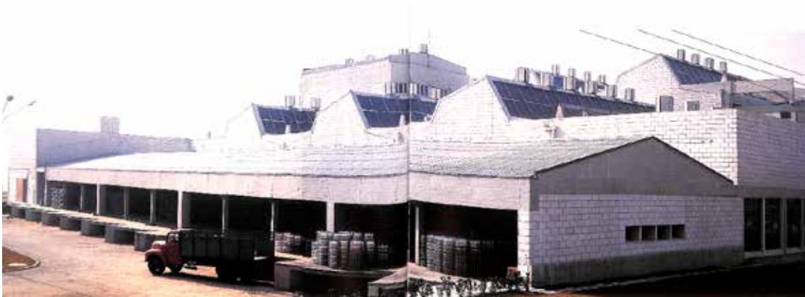
Fig 8. Almacén de productos.
