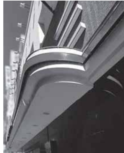
Fig 6. Marquesina de entrada.
