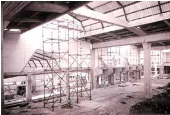
Fig 6. Lucernarios de la naves.
