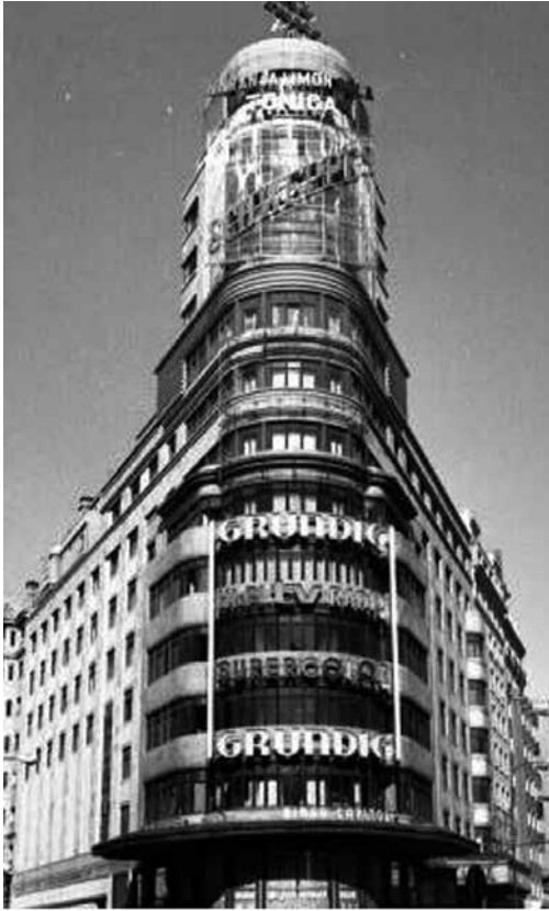
Fig 5. Vista desde la calle.
