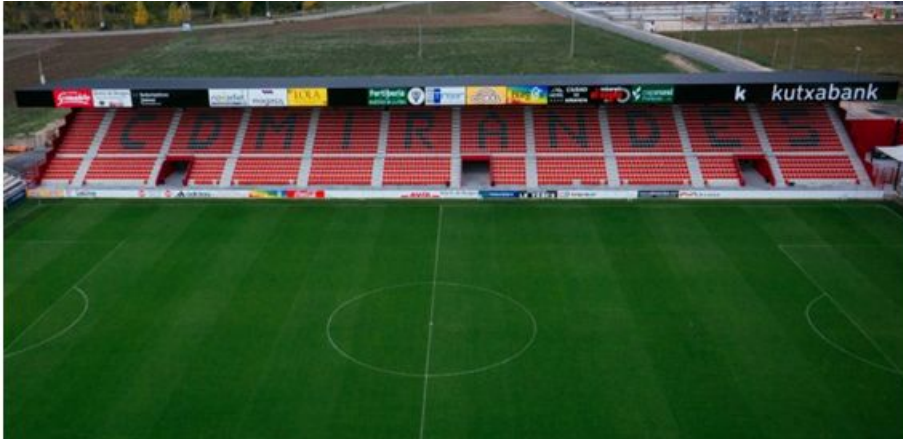
Figura 14. Nueva Grada General del Estadio de Anduva. (09/2015)
