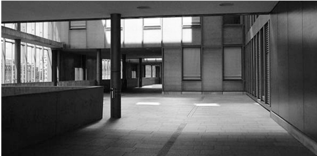
Figura 11: Detalle del espacio interior del edificio Peter-Merian-Haus de Hans Zwimpfer, construido entre 1994 y 2000. Fuente: © Inge Kanakaris-Wirtl. Recuperado de https://structurae.net/structures/peter-merian-haus
