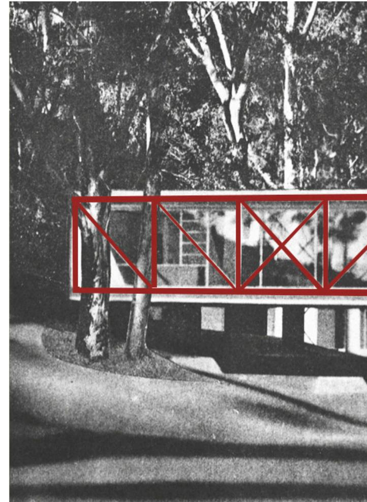
i.6 Estructura de acero entramada de la *Bridge House*.
