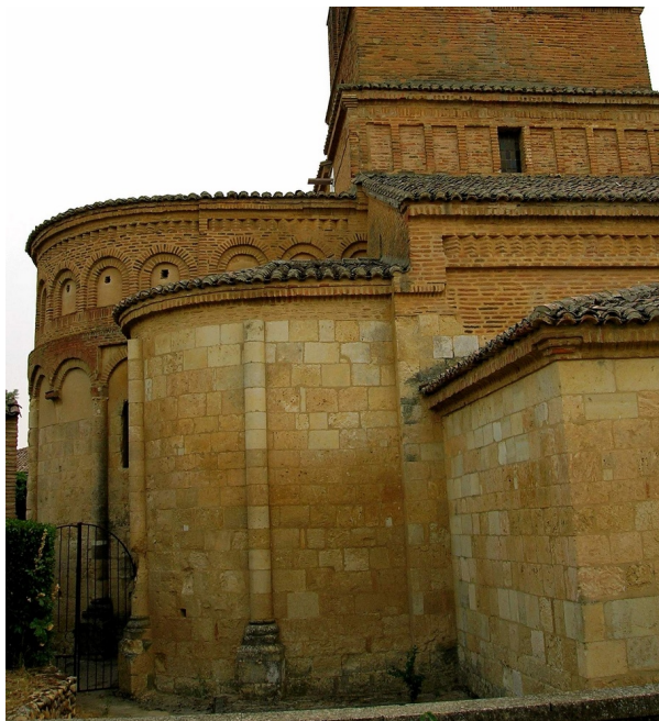
Interior de la nave del evangelio y exterior de la cabecera de la iglesia del monasterio de San Pedro de las Dueñas.
