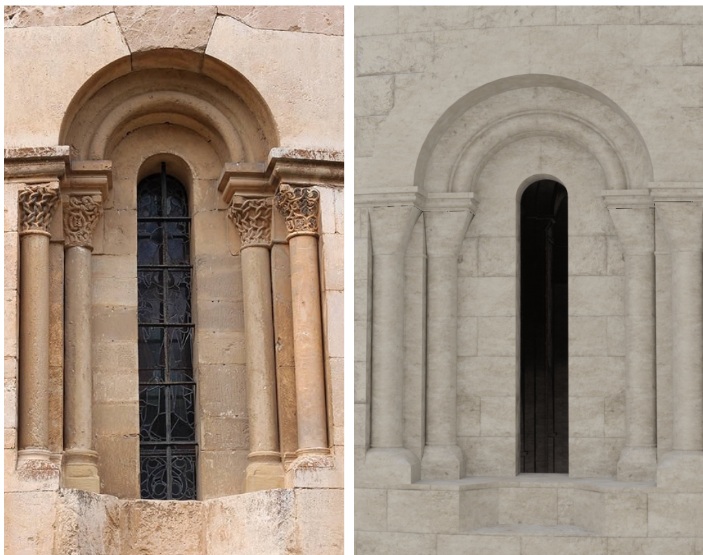
Ventana del ábside central del monasterio de Santa María de Bujedo y vista exterior de la ventana del modelo.
