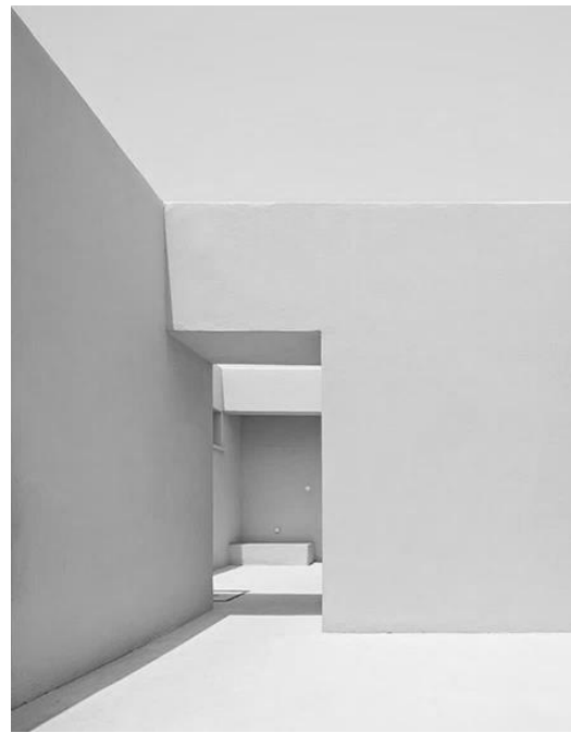
FIGURA 138: VISTA DE ACABADOS EXTERIORES
