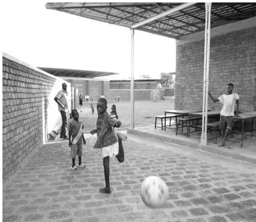
FIGURA 156: VISTA EXTERIOR- CERRAMIENTOS Y CUBIERTA
