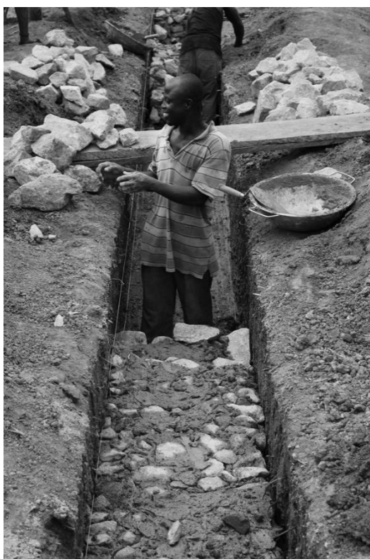
FIGURA 174: CONSTRUCCIÓN DE LA CIMENTACIÓN
