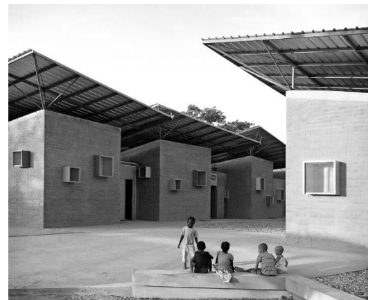
FIGURA 109: VISTA EXTERIOR DE LOS VOLUMENES MODULARES DEL CENTRO SANITARIO
