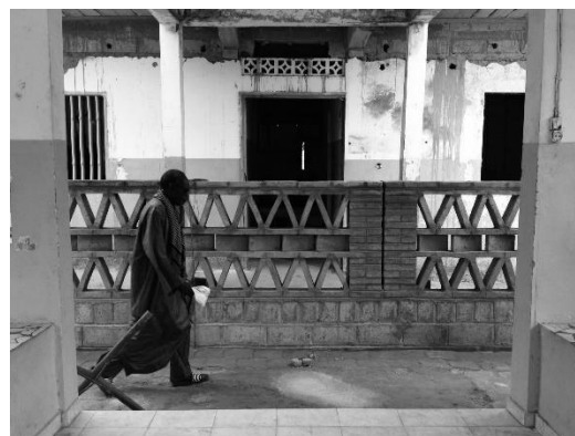
FIGURA 69: PETO EXTERIOR DE LADRILLOS DE TIERRA COMPACTA
