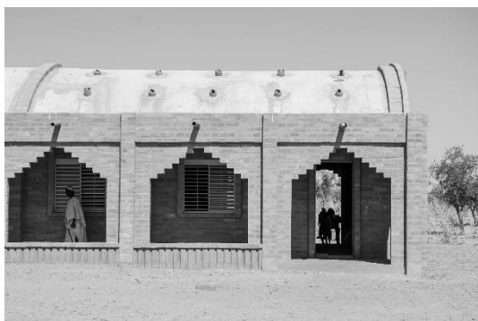
FIGURA 193: VISTA LATERAL PÓRTICO- GALERÍA LONGITUDINAL
