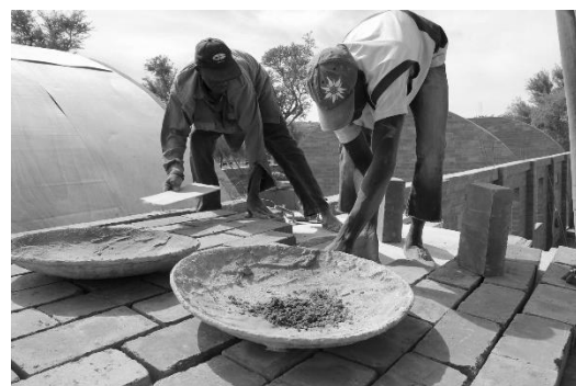
FIGURA 203: IMPERMEABILIZACIÓN DE CUBIERTA
