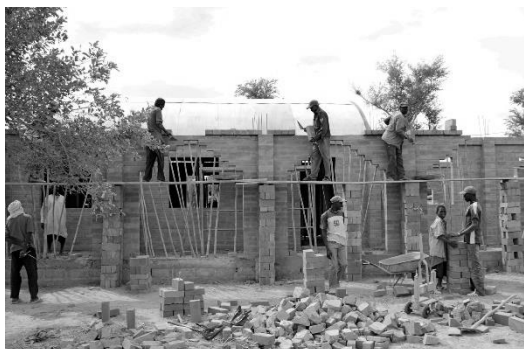
FIGURA 201: CONSTRUCCIÓN DE LOS CERRAMIENTOS
