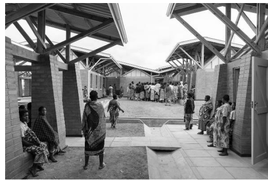
FIGURA 92: VISTA EXTERIOR- CANALIZACIÓN INFERIOR VISTA DE AGUAS PLUVIALES
