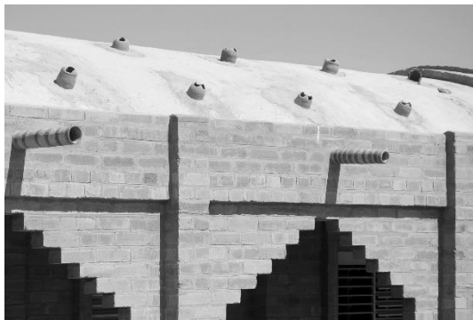
FIGURA 197: VISTA EXTERIOR DETALLE DE LA CUBIERTA: TRONERAS - EVACUACIÓN DE AGUA
