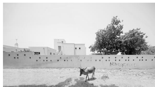
FIGURA 128: VISTA EXTERIOR DEL CERRAMIENTO PERIMETRAL
