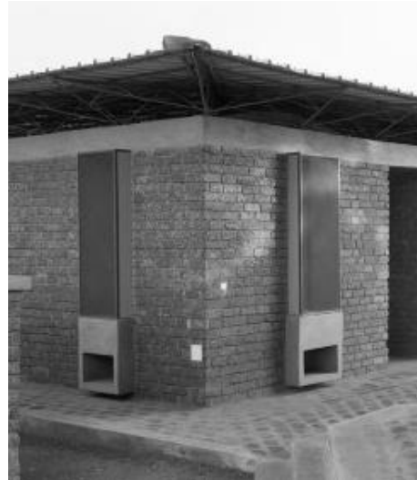
FIGURA 154: SISTEMA DE FENESTRACIÓN DE LAS VENTANAS
