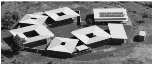
FIGURA 152: VISTA AEREA DEL CONJUNTO EDIFICATORIO Y PATIOS SUBYACENTES
