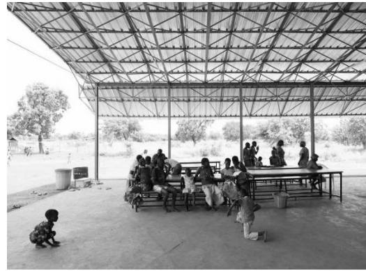
FIGURA 157: CUBIERTA ABIERTA COMEDOR
