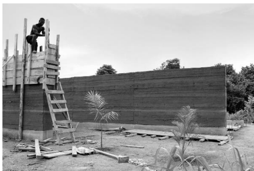
FIGURA 178: CONSTRUCCIÓN DE LOS MUROS
