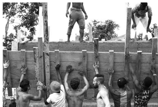
FIGURA 176: ENCOFRADOS DE MADERA PARA CERRAMIENTOS DE TIERRA COMPACTADA
