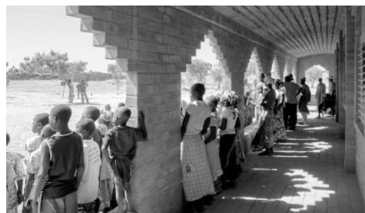
FIGURA 194: VISTA INTERIOR PORTICO LATERAL
