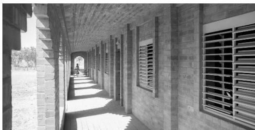
FIGURA 190: VISTA GALERIA LONGITUDINAL LATERAL
