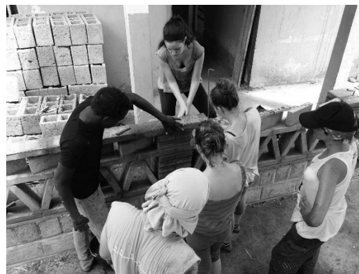
FIGURA 70: CONSTRUCCIÓN DEL PETO EXTERIOR
