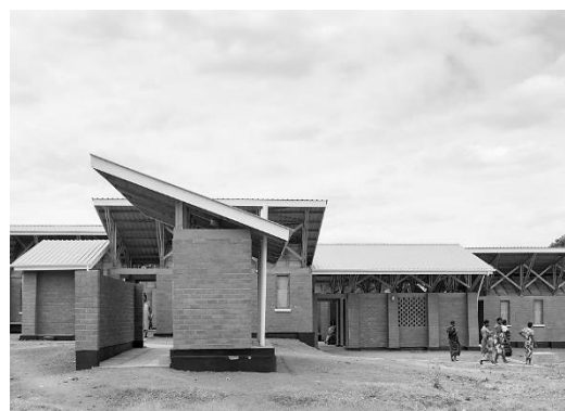
FIGURA 84: VISTA EXTERIOR LATERAL DE LA ALDEA DE MATERNIDAD
