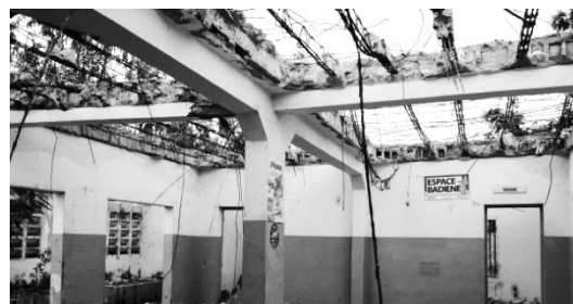
FIGURA 52: DEMOLICIÓN DE LOS FORJADOS DETERIORADOS
