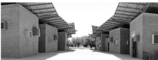
FIGURA 108: VISTA EXTERIOR DESDE EL EJE CENTRAL
