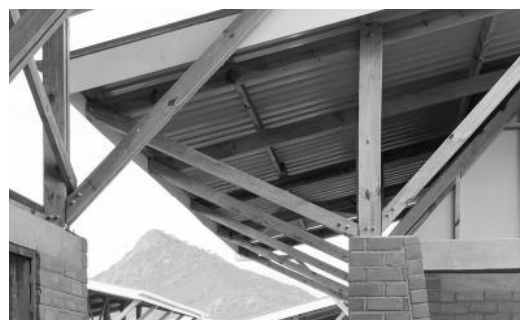
FIGURA 95: SOLUCION DE CUBIERTA Y APOYOS
