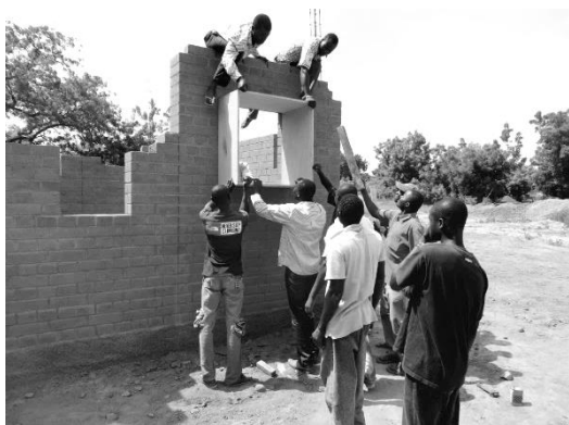
FIGURA 112: CONSTRUCCIÓN DE MUROS DE CERRAMIENTO Y COLOCACIÓN DE CARPINTERIAS EXTERIORES
