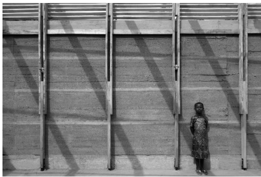
FIGURA 177: ESTRUCTURA DE MADERA - PAREDES CRUJIA
