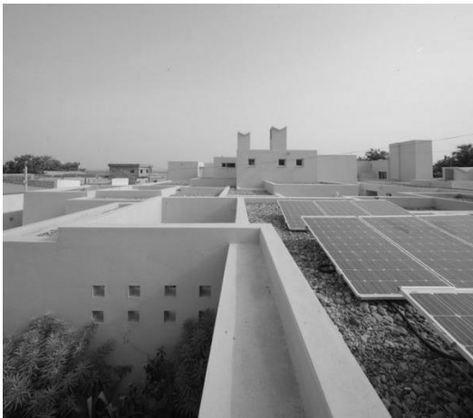
FIGURA 133: VISTA EXTERIOR. CUBIERTA PLANA Y PANELES FOTOVOLTAICOS
