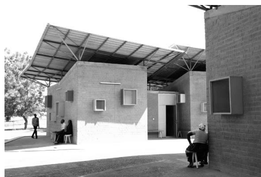
FIGURA 113: VISTA EXTERIOR: CUBIERTA DE CHAPA METÁLICA- MUROS DE LADRILLO DE TIERRA COMPACTADA - DISPOSICIÓN DE CARPÍNTERIAS
