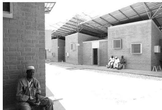
FIGURA 103: VISTA EXTERIOR VOLUMENES MODULARES
