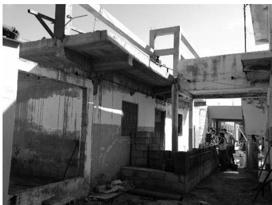
FIGURA 57: PROCESO DE EDIFICACION ESTRUCTURAL
