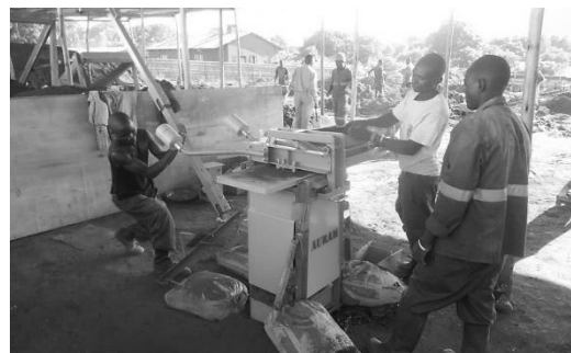
FIGURA 94: CONSTRUCCIÓN BLOQUES DE TIERRA ESTABILIZADA COMPRIMIDA CSEB
