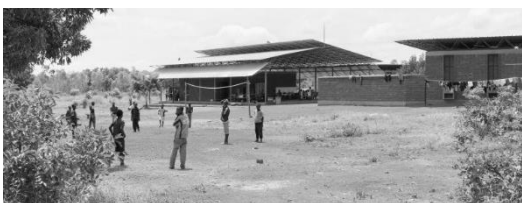
FIGURA 153: VISTA EXTERIOR DEL CONJUNTO
