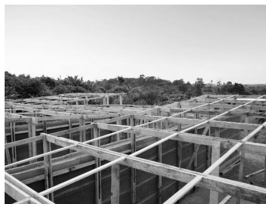
FIGURA 175: ESTRUCTURA DE MADERA DEL EDIFICIO
