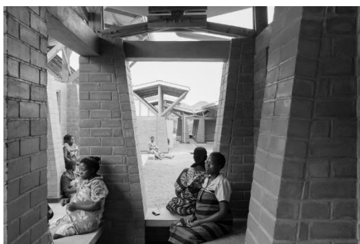
FIGURA 93: COLUMNAS REFORZADAS DE CSEB
