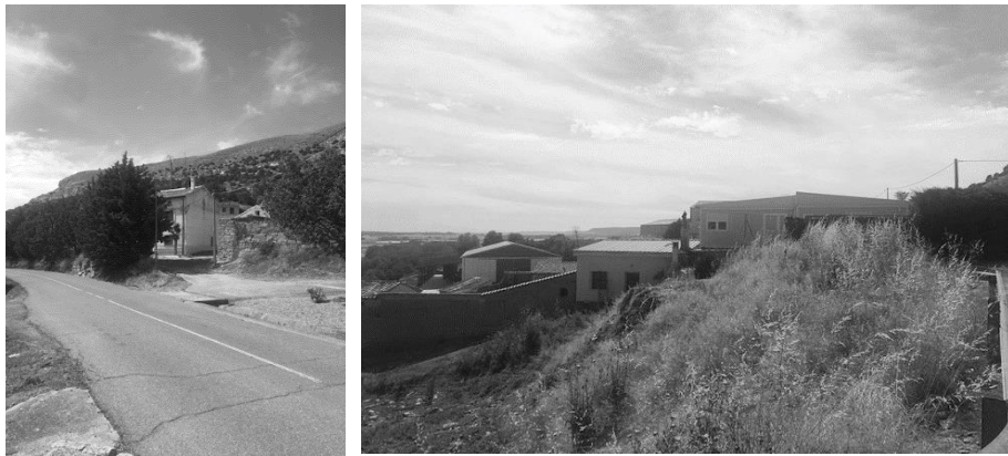
Ilustración 33; Sección 1, Inmueble. REF. Propia
