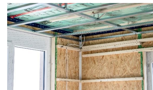
FIG.59_Interruptores y enchufes básicos en una vivienda flotante.
