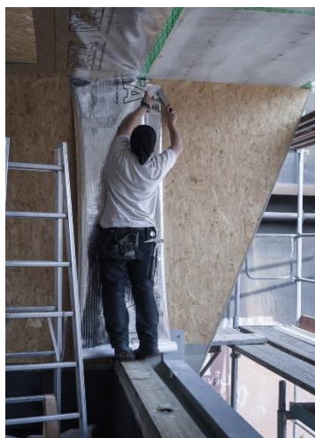
FIG.48_Montaje de la Carpintería. FIG.49_Instalación de la Perfilera de la Carpintería.
