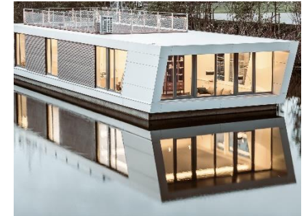
FIG.50_Vivienda Terminada equipada con carpinterías correderas.
