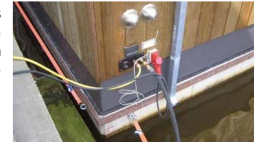
FIG.111_Conexión a la Red de Abastecimiento Municipal de Aguas FIG.112_Bomba de Aguas Residuales FIG.113_Conexión a la Red Eléctrica
