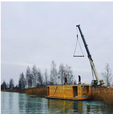
FIG.106_El municipio puede supervisar las tareas de construcción de la Vivienda Flotante en la parcela de agua o amarre habilitado.
