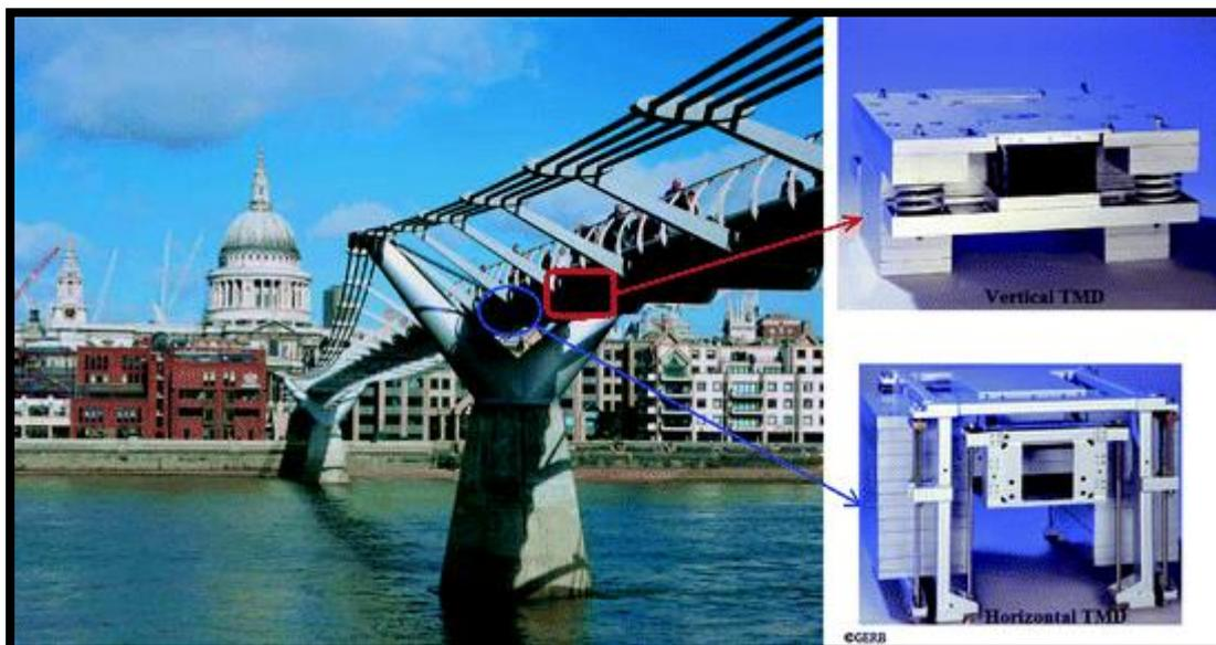
Figura 1. TMD instalados sobre la pasarela Millenium Brigde en Londres [2]
