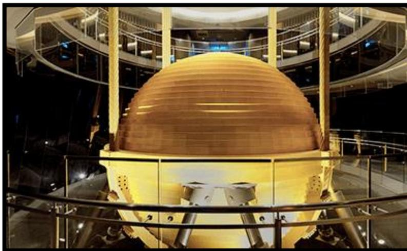
*Figura 5. TMD situado en el rascacielos Taipéi 101 [6]*
