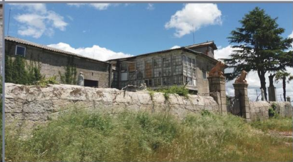
Muro y fachada principal del pazo.
