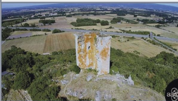
Vista panorámica desde la torre.
