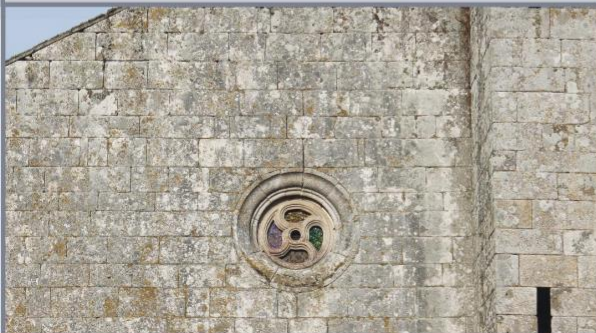
Rosetón de pequeño diámetro ubicado en la fachada de la Iglesia.
