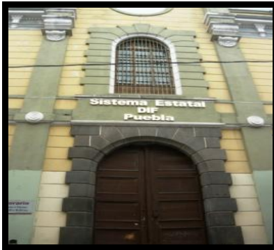
Fig. 204.- Sistema Estatal DIF de Puebla ubicado sobre la calle 5 de Mayo dentro del sector 2 (Fuente: FOMIX Folio MN001-2007-C01-63353)
