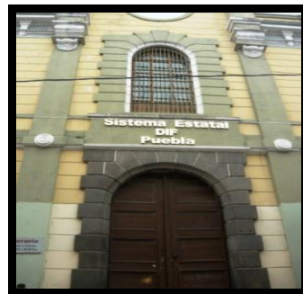
Fig. 132 Enmarcamiento de puertas y vanos del edificio DIF (Fuente: M. Carreño)
