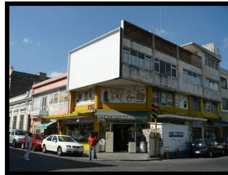
Fig. 207. Refaccionaria ubicada entre la 4 norte y 12 ote. (Fuente: FOMIX Folio MN001-2007-C01-63353)
