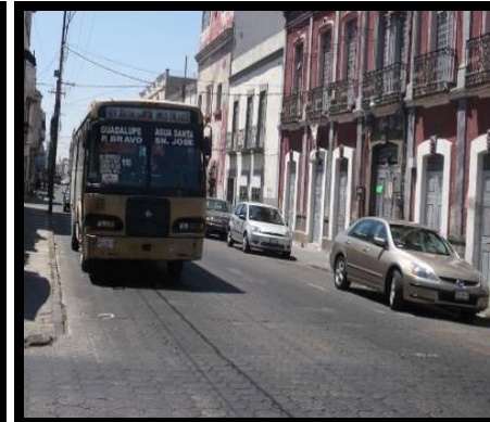
Fig. 185 y 186 Se muestra el estado actual y de conservación de la carpeta asfáltica y del adoquín de las calles. En general se considera de regular a bueno. (Fuente: FOMIX Folio MN001-2007-C01-63353)
