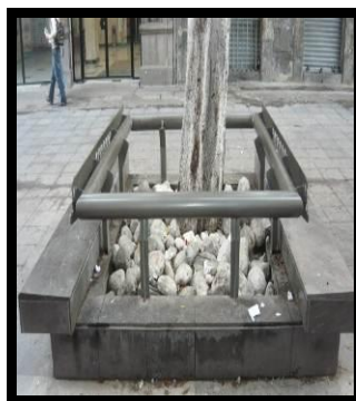
Fig. 146 Tipología actual de bancas formando una barrera de protección a los arboles calle 5 de Mayo (Fuente: M. Carreño)
