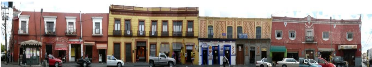
Fig. 301. Fachada Pte. calle 2 Nte.; entre 16 y 18 Ote. Fuente: FOMIX Folio MN001-2007-C01-63353
