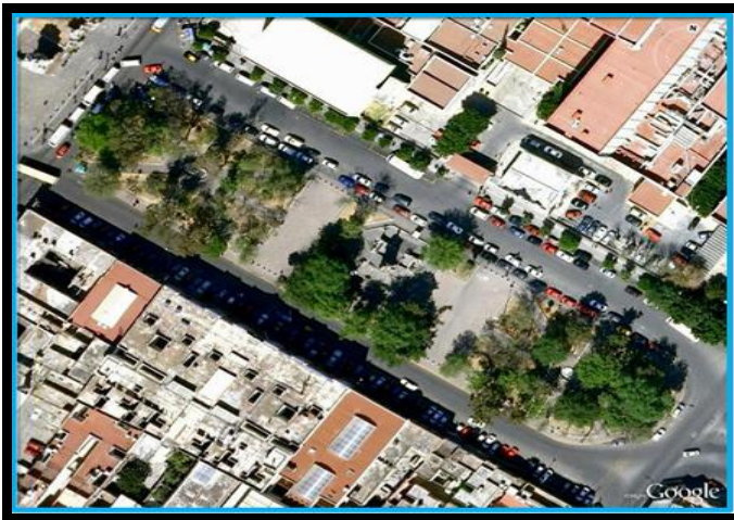
Fig. 114 Fotografía aérea del Jardín Fco. I. Madero Fuente: Google Earth (Taller Proyectos II M. Carreño)
