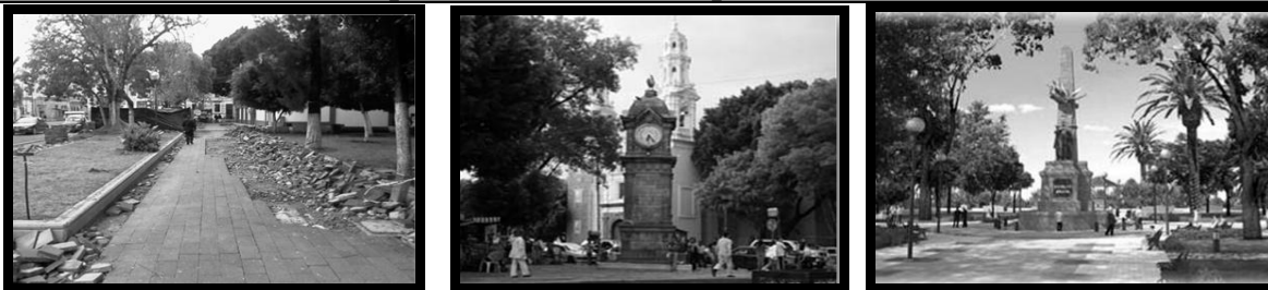
Figura 33-35 Se muestran los trabajos de rehabilitación que se realizaron en el Parque Paseo Bravo que aún conserva algunos de los principales hitos de la ciudad
