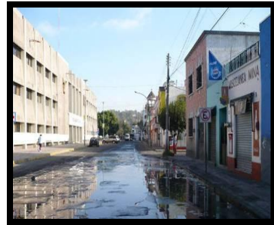
Fig. 127 Contraste en la tipología urbano-arquitectónica 4 norte y 12 Ote. a la izquierda el Hospital Regional, a la derecha el fraccionamiento San Francisco. (Fuente: FOMIX Folio MN001-2007-C01-63353)
