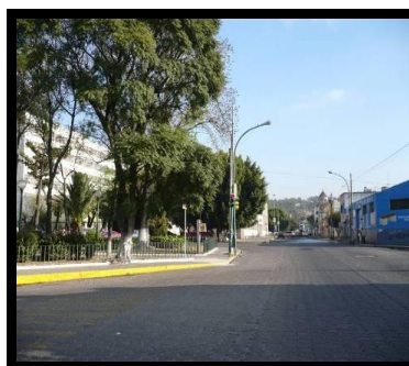
Fig. 118 Vista del Jardín Francisco I. Madero desde la esquina de la 4 Nte. hacia la 18 Ote. Se percibe el paisaje urbano del barrio cuyo remate visual lo conforma la Parroquia de San José. (Fuente: FOMIX Folio MN001-2007-C01-63353)
