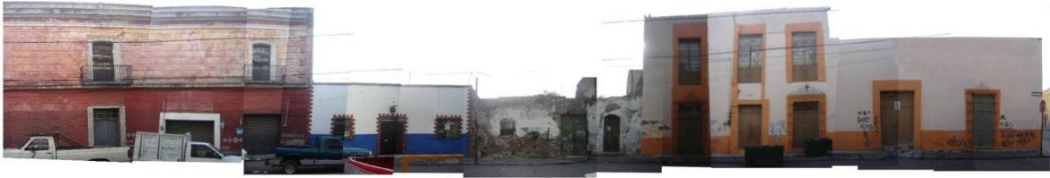
Fig. 295. Levantamiento en larguero de edificios contiguos. Elaboración propia
