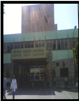
Fig. 165 Hospital Regional Manuel Ávila Camacho (IMSS) (Fuente: M. Carreño, 2011)
