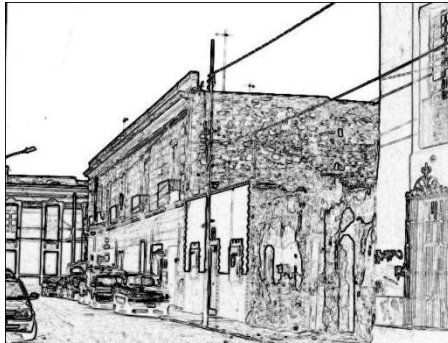
Fig. 275. Levantamiento fotográfico de edificios contiguos. Elaboración propia
