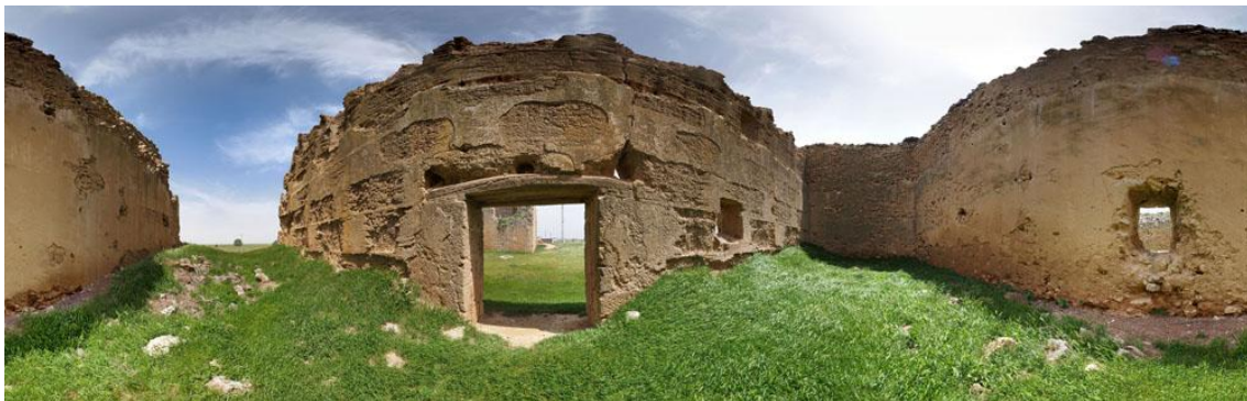
Figura 8.15: Imagen panorámica 360, vista interior de una antigua panera de trigo, Castillo de Villagarcía de Campos, Valladolid.
