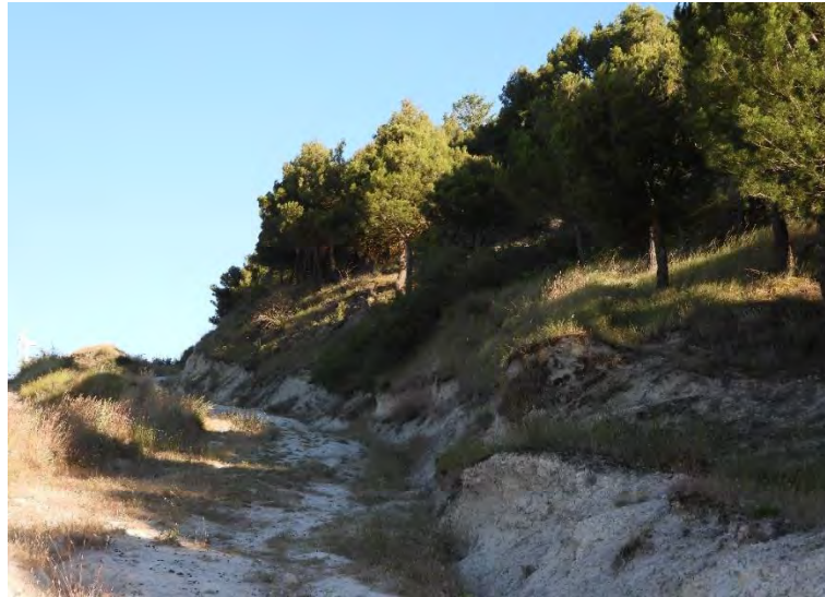
fig. 12 Vía del camino del Cotorrón
