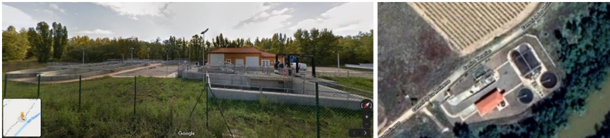
Figura 8. Imágenes de la EDAR de Roa.
