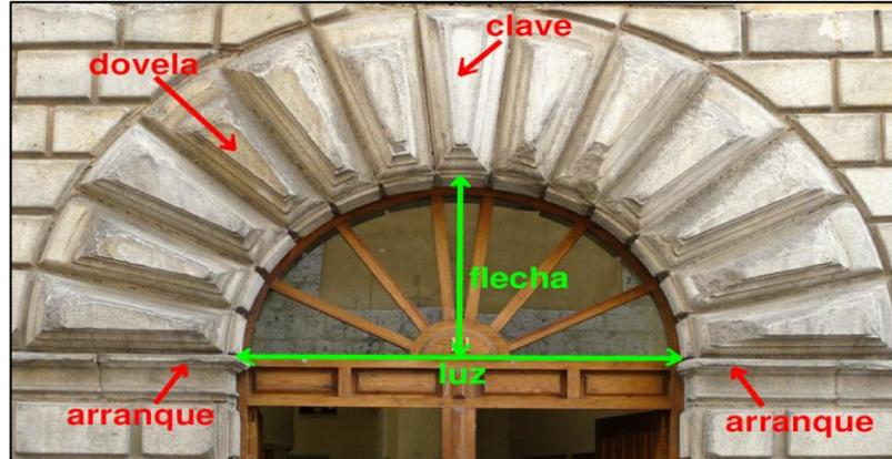
Figura 3.3.7. Partes de un arco
