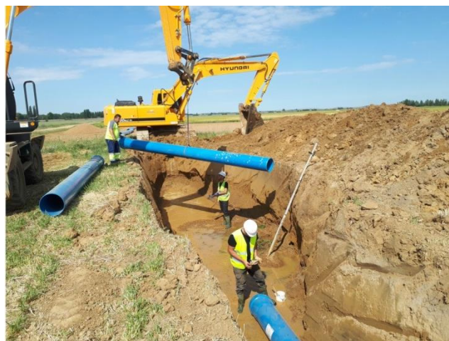
Fotografía Colocación de tuberías TOM de PVC Orientado (PVC-O), en las obras de las vegas bajas del río Valdavía
