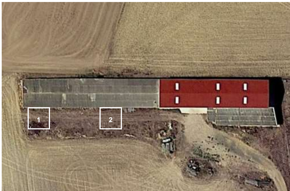
Figura 1. Ubicación e identificación de las calicatas.
