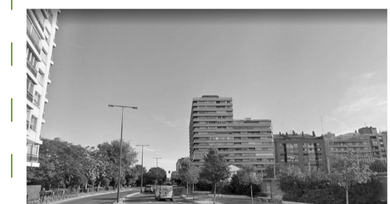
Vista exterior del área donde se proyectará el edificio
