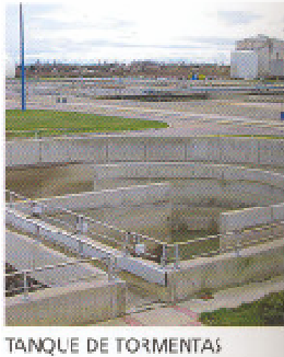
TANQUE DE TORMENTAS
