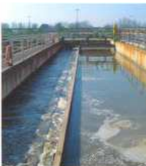
CANAL DE DESARENADO Y DESENGRASADO
