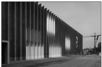
En el edificio propuesto, la estructura vertical portante se saca al exterior, de forma que los pilares apuntalados de hormigón se sitúan cada 3 m, dando un ritmo a la fachada siguiendo la misma estrategia que Barozzi & Veiga.
