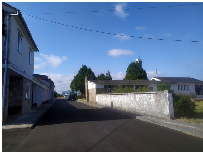
Fig. 106. Escuela y viviendas.
