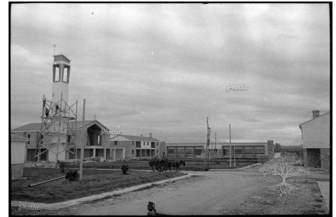
Fig. 31. Construcción del Centro Cívico de Matodoso, 1964.
